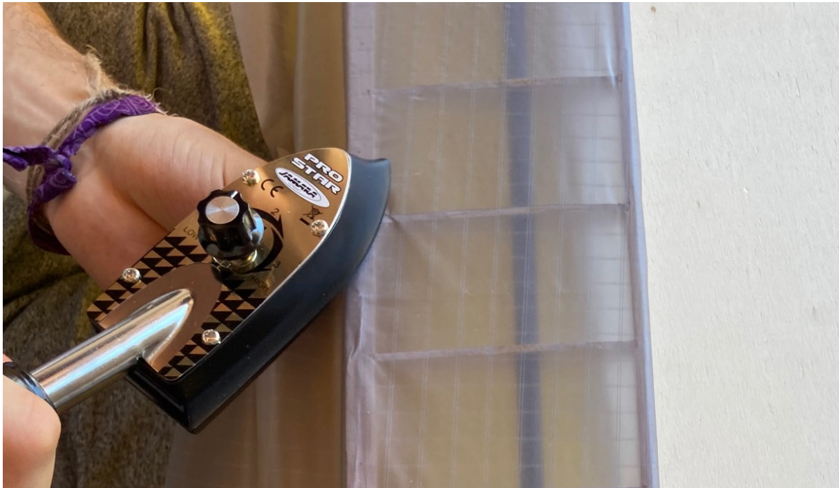
Figura 4.9. Detalle del proceso de revestimiento
