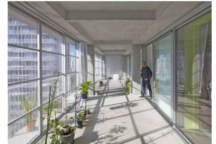
Fig 130. Transformación de 530 viviendas sociales Lacaton & Vassal (2016) Grand Parc Bordeaux, Francia
