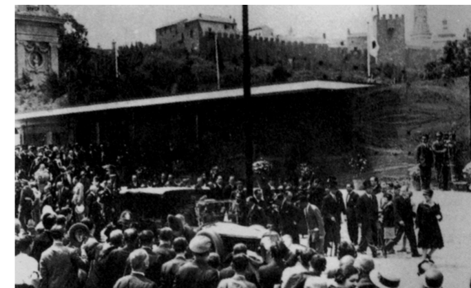
Fig 3. Día de la inauguración Mies van der Rohe Pabellón de Barcelona (1929)
