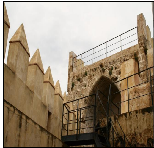
Figura 26. Torre Noroeste. Fuente: Flickr.
