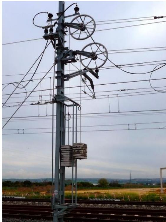
FIGURA 3 - SISTEMA DE TENSIONADO DE UNA CATENARIA [8].
