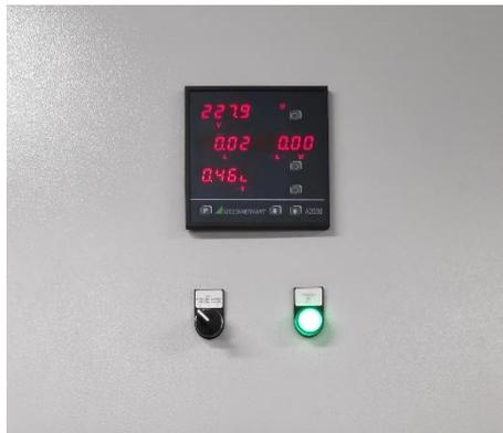
Figura 43. Display analizador de redes A2000.
