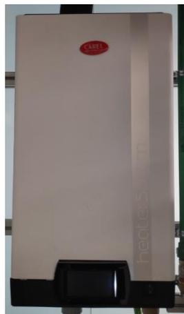
**Figura 35. Generador de vapor.**
