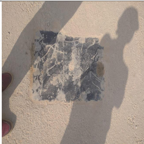
*PLACA DE ANCLAJE INSTALADA
