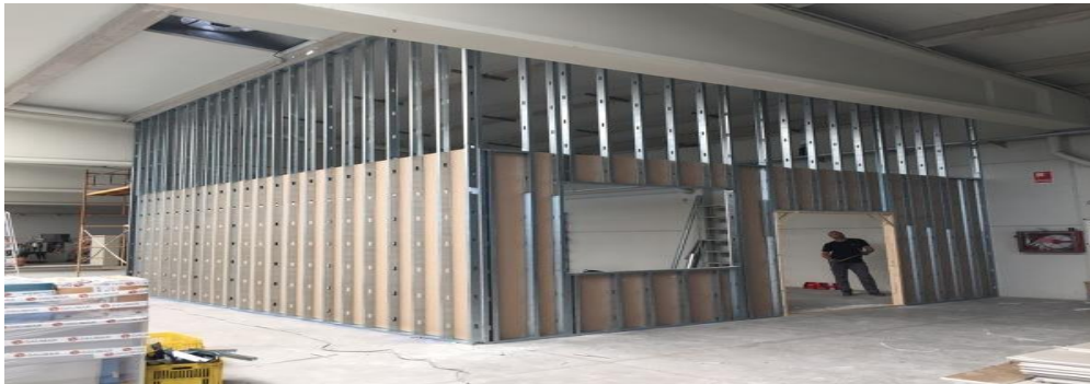
IMONTAJE OFICINA PLADUR
