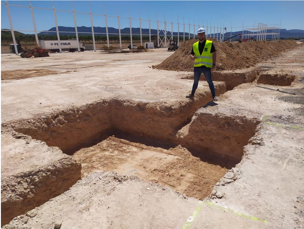
IESCAVACIONES ZAPATAS Y VIGA ARRIOSTRADA
