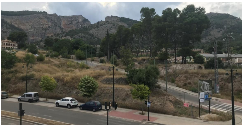
Ilustración 2.2.4.- Estado actual de "Odina Homes".
