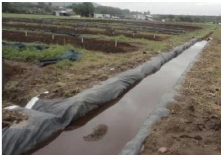
Figura 20. Canaleta para recoger lixiviados.
