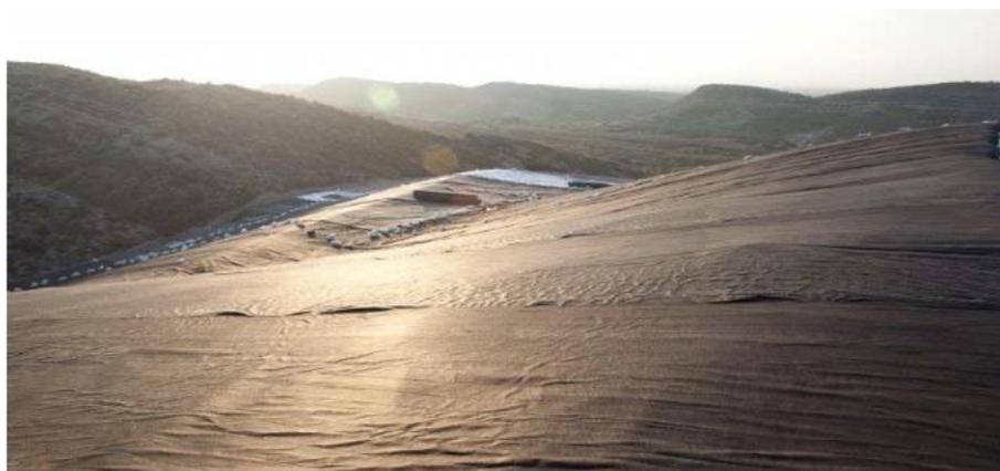
**Figura 19. Impermeabilización del terreno.**
