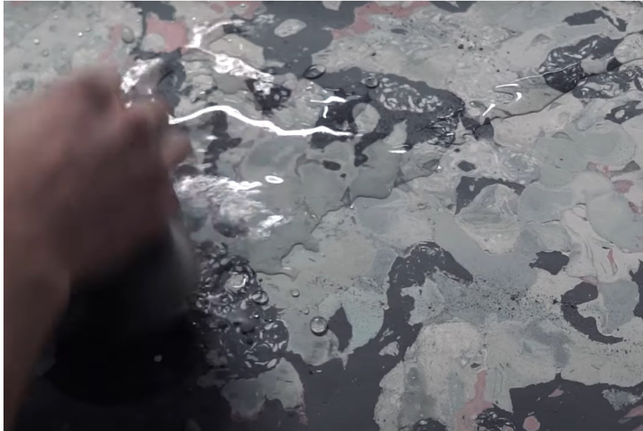
Ilustración Anexo 6: Relleno de las cavidades.
