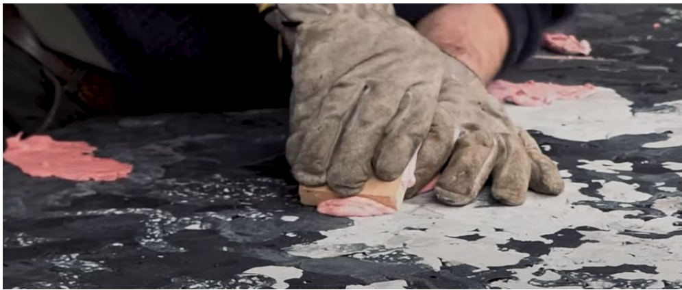
Ilustración Anexo 6: Relleno de las cavidades.
