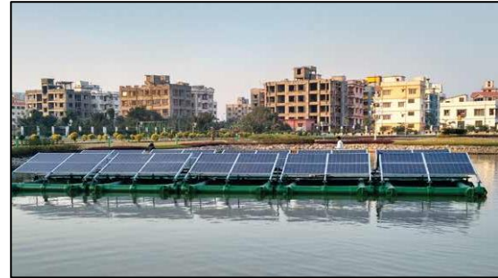
Figura 15. Sistema con Estructura Metálica y Tubos
