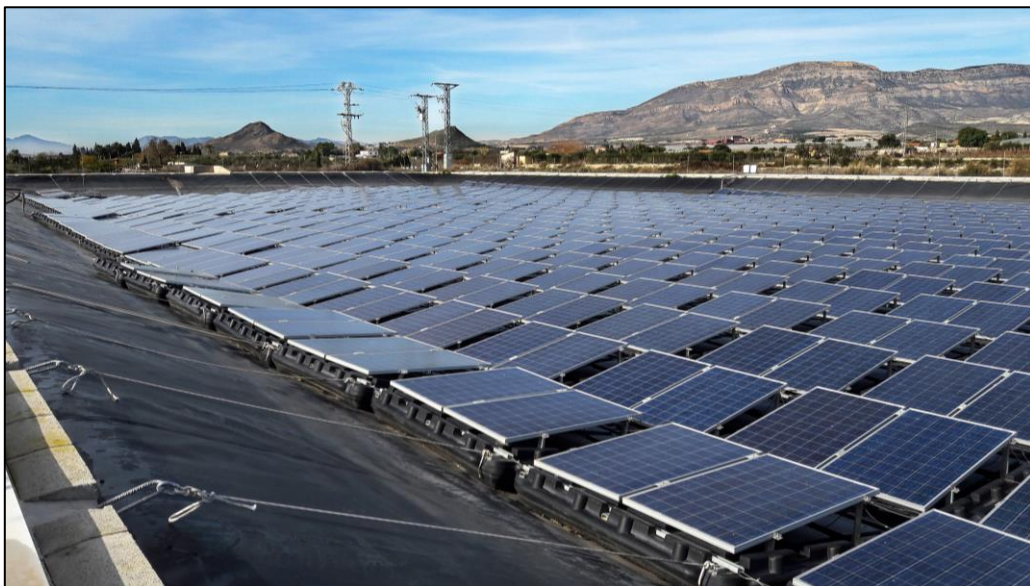
Figura 6. Primera Instalación FPV Modular del Mundo
