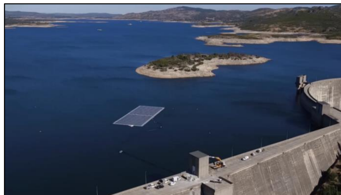
Figura 19. Instalación FPV próxima a Presa Hidroeléctrica
