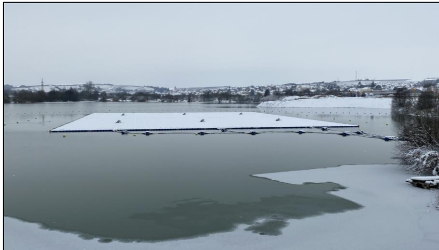
Figura 18. Instalación FPV cubierta de Nieve
