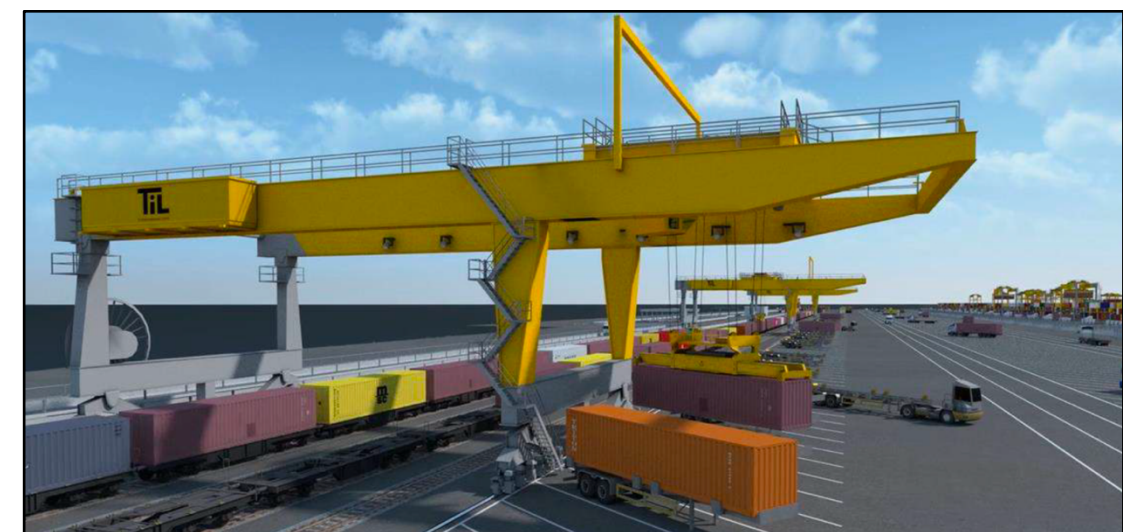
Ilustración 29 Operación de entrega/recepción en la terminal ferroviaria CRMG con UTT. Fuente: TiL/MSC
