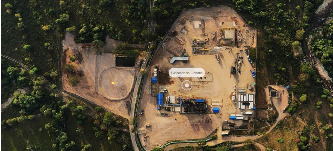
Figura 18. Punto de Compresión de GNC en Capachos, Departamento de Arauca.
