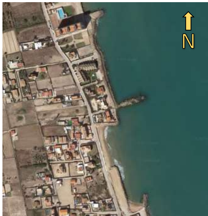
Figura 6. Protecciones longitudinales y espigón deteriorado
