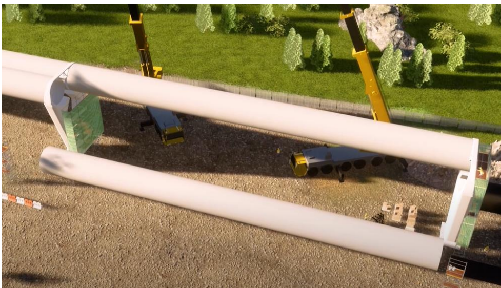
Figura 13. Proceso constructivo del módulo del tubo para el modelo propuesto por Zeleros-UPV. Fuente: Zeleros-UPV
