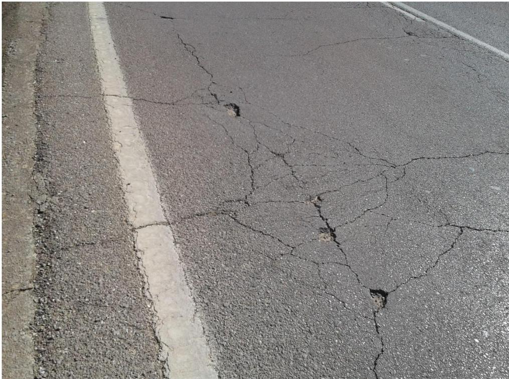
Foto nº 21: P.K. 13+930. Presencia de grietas en arcén y margen derecho.
