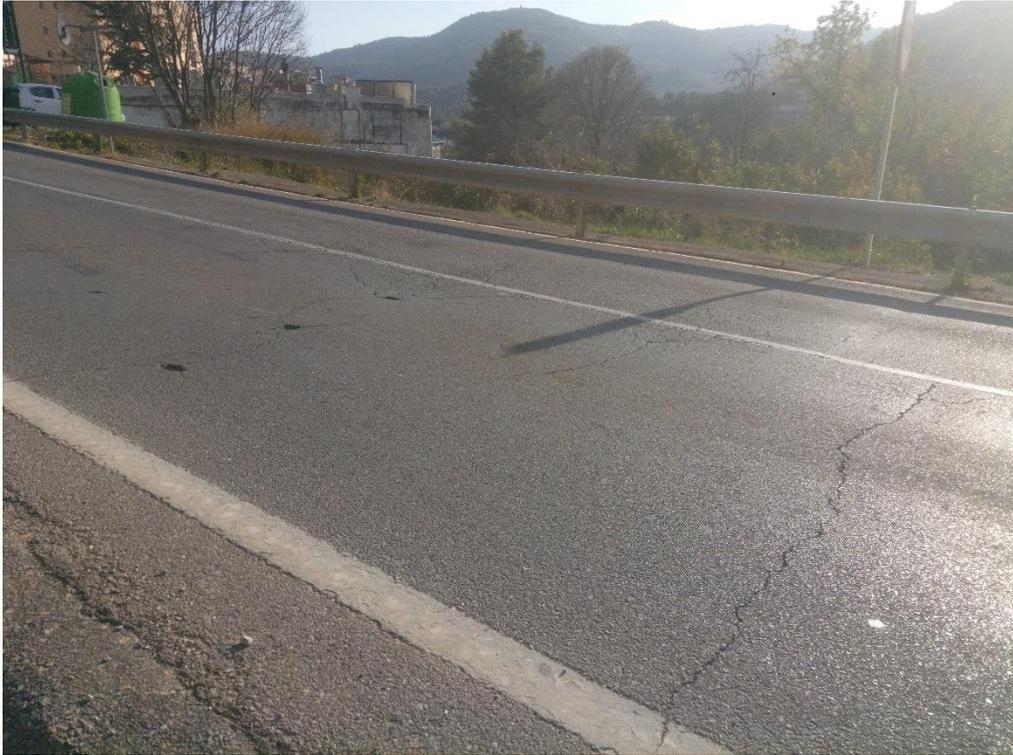
Foto nº 16: P.K. 13+925. Presencia de grietas transversales y peladuras en margen derecho
