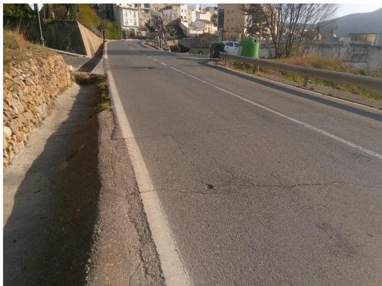
*Figura 24: Obra de drenaje longitudinal existente en el tramo de carretera*
