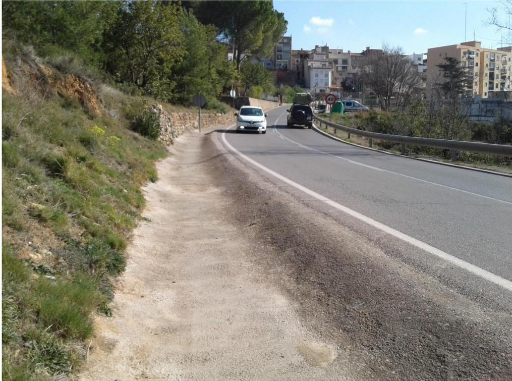
Foto nº 18: P.K. 13+960. Cuneta longitudinal en margen derecho.
