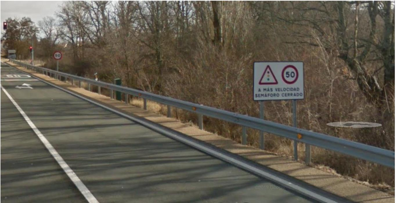
Figura 13: Vista de la señalética a semáforo con control de velocidad en la carretera N-234 a su paso por Cidones, Castilla y León.
