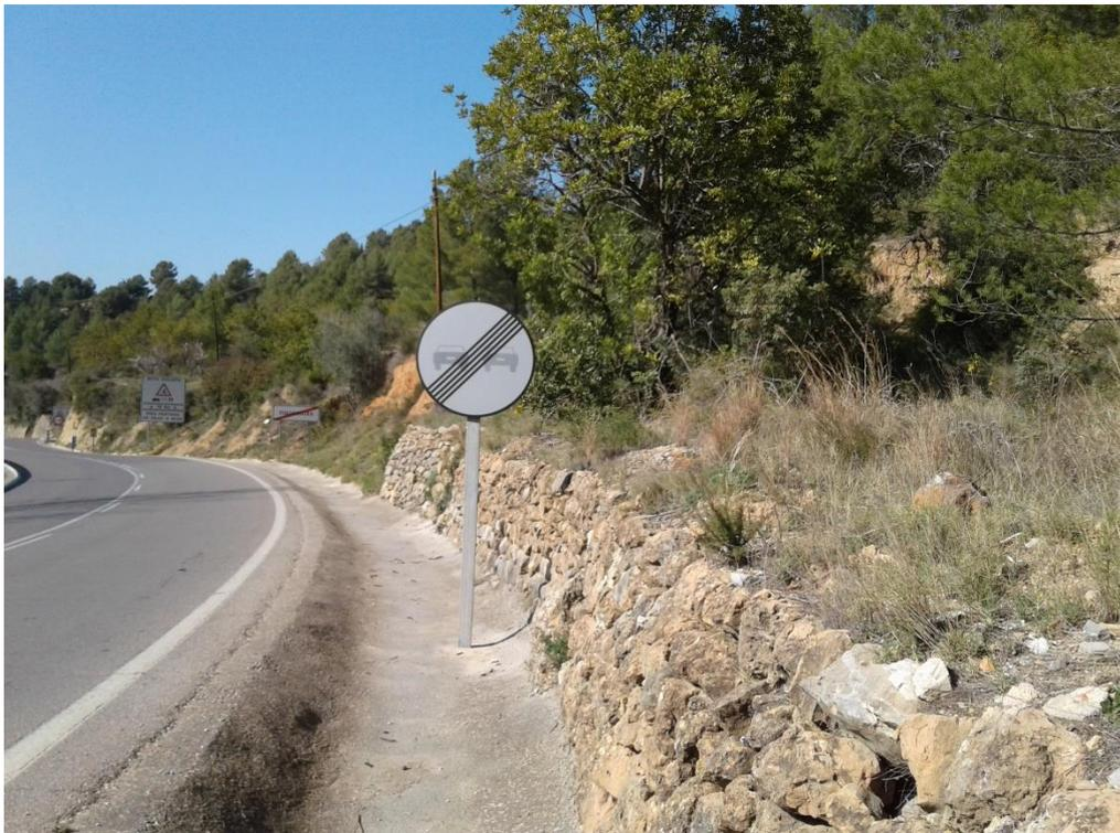
Foto nº 19: P.K. 13+930. Cuneta longitudinal en margen derecho.
