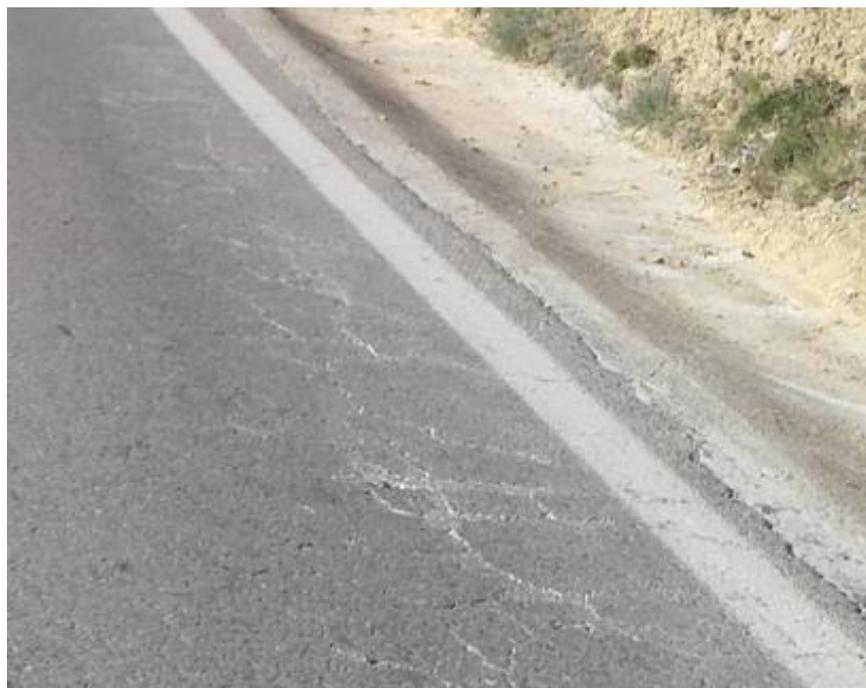
Figura 6: Cuarteo (piel de cocodrilo) y roderas en carril derecho según sentido de avance de pk's
