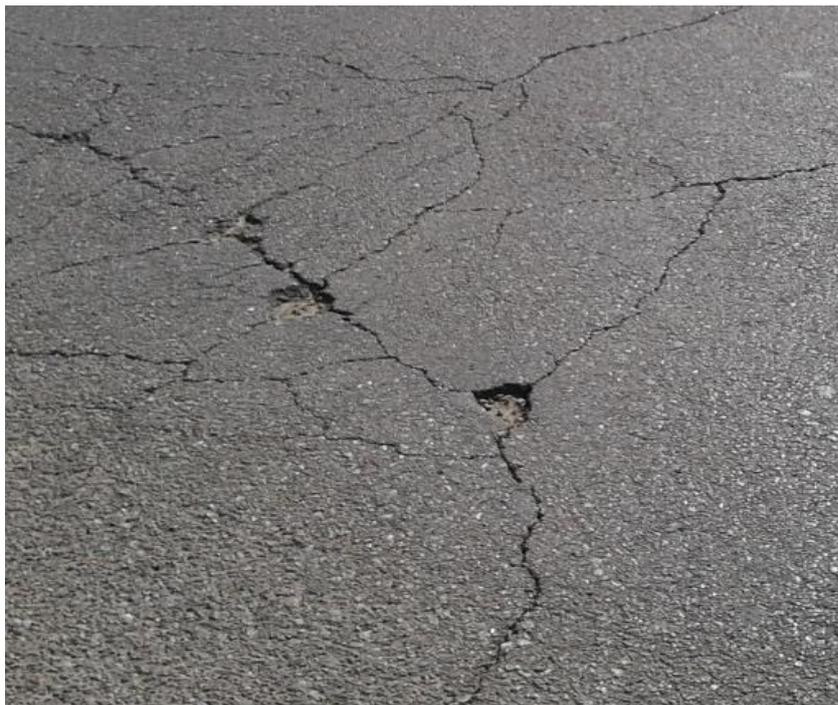
*Figura 10: Pérdida de árido de la capa de rodadura (peladuras)*
