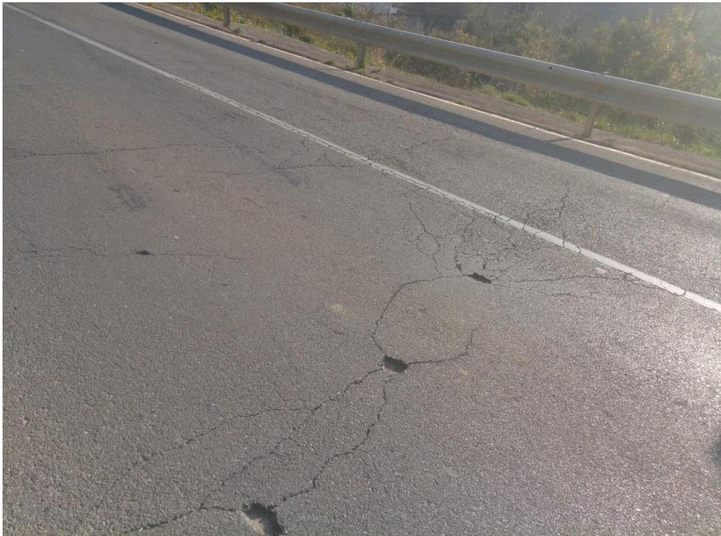
Foto nº 15: P.K. 13+925. Presencia de grietas transversales y peladuras en margen derecho
