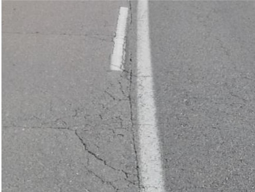
*Figura 9: Agrietamientos longitudinales*
