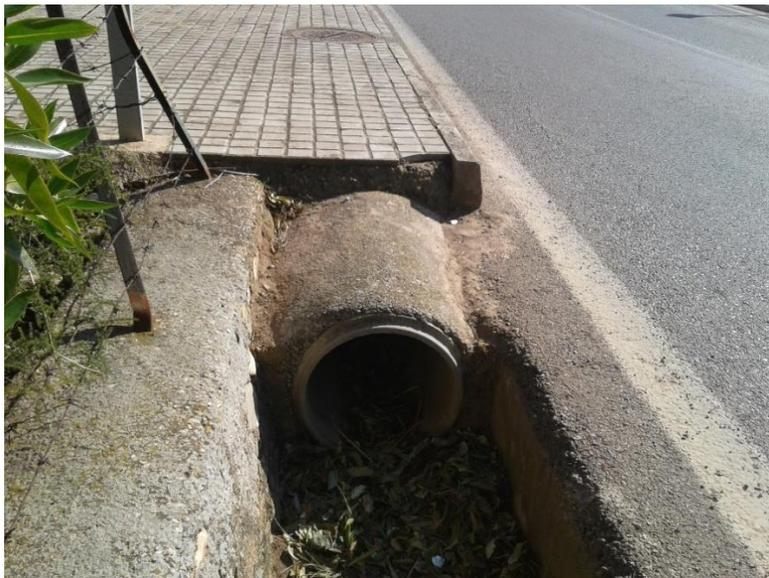
*Figura 23: Obra de drenaje longitudinal existente en el tramo de travesía. Colector de hormigón de diámetro 400 mm*
