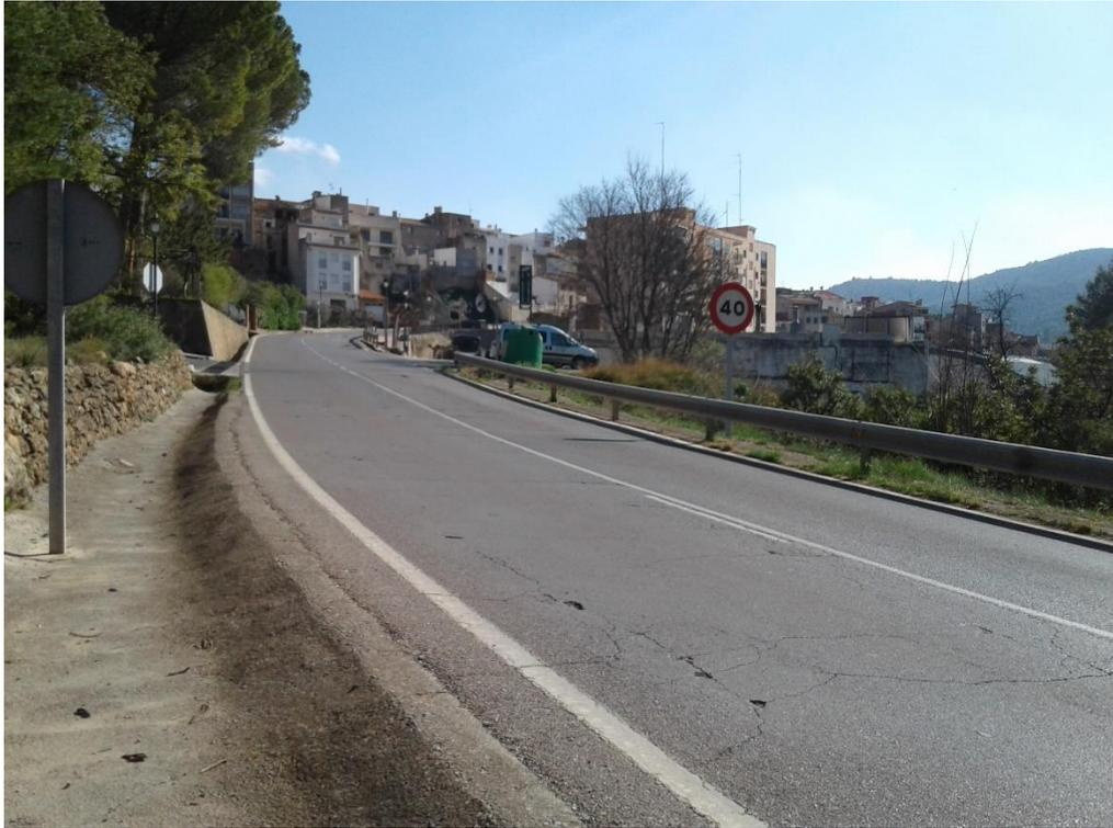
Foto nº 20: P.K. 13+930. Presencia de grietas en arcén y margen derecho.
