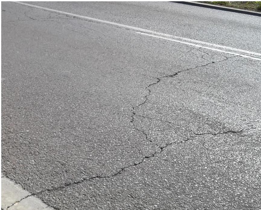
*Figura 8: Agrietamientos transversales*
