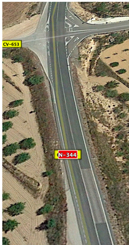
Figura 5. Parche en la N-344. Fuente: Google Earth.
