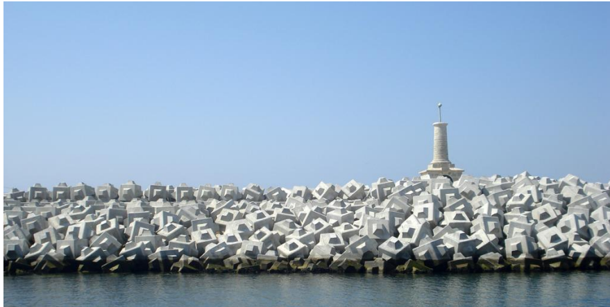
Figura 32: Dique cubípodos del Puerto de Málaga. Fuente: abc.es
