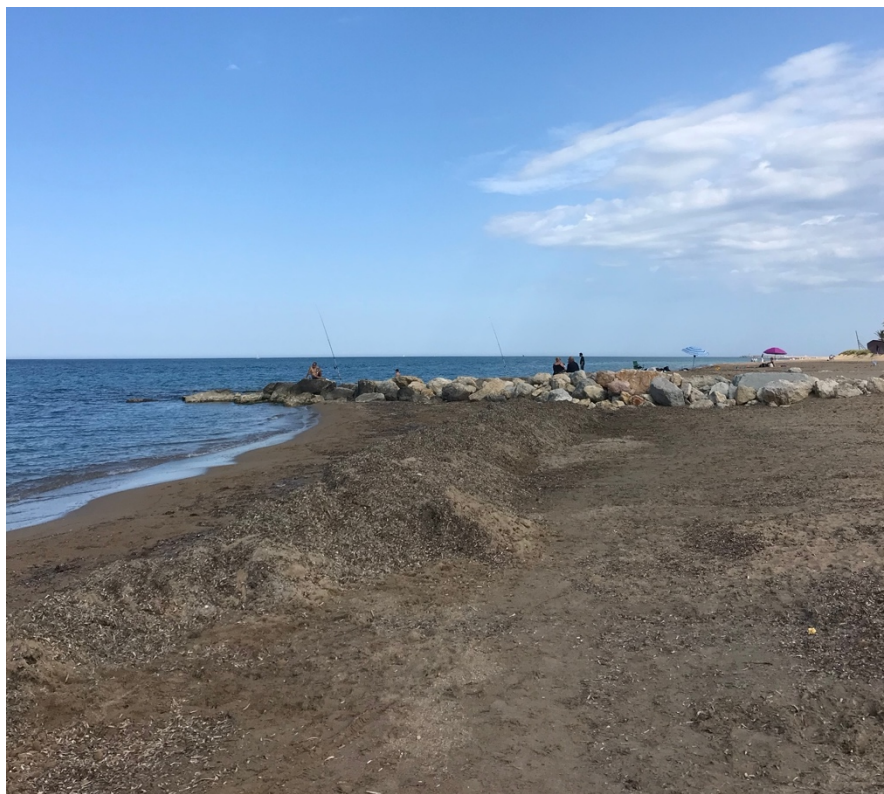
Figura 10. Fotografía inicio espigón desmantelado. Fuente: Elaboración propia.
