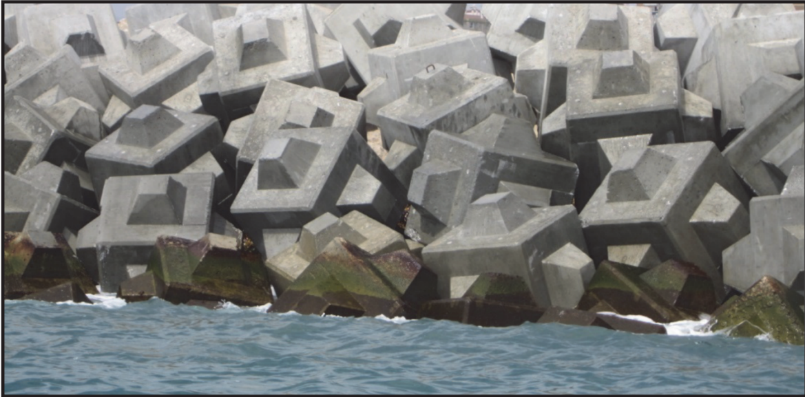
Figura 2: Cubípodos de 6t en el dique de San Andrés (Málaga). Fuente: Manual del cubípedo.
