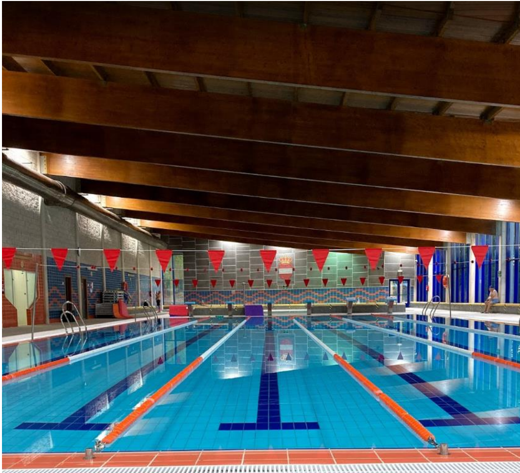
Figura 6. Cubierta formada por pilares metálicos y vigas de madera laminada de directriz recta. Piscina municipal Modesto Eiroa de Puertollano, Ciudad Real. Fuente: https://www.google.es/maps/place/Piscina+Cubierta+Municipal+Modesto+Eiroa/@38.681944,-4.1036111,19a,66.6y/data=!3m8!1e2!3m6!1sAF1QipNj1sjGoTIFAPZdgoafLVOgUPRbsHeim6r7AFC!2e10!3e12!6shttps:%2F%2Fh5.googleusercontent.com%2Fp%2FAF1QipNj1sjGoTIFAPZdgoafLVOgUPRbsHeim6r7AFC%3Dw86-h114-k-no!7i3024!8i4032!4m8!1m2!2m1!1spiscina+municipal+puertollano+ciudad+real!3m4!1s0xd6b8c8c3f201d2f:0x447ad9ced15362a1!8m2!3d38.6819444!4d-4.1036111?hl=es
