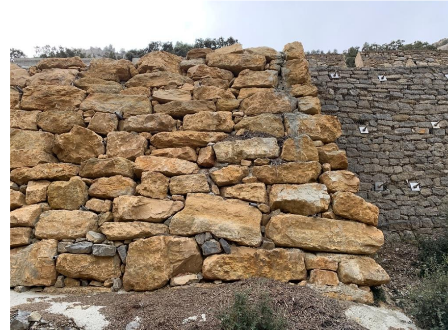
Ilustración 41 Detalle, muro de escollera. Fuente: Elaboración propia.
