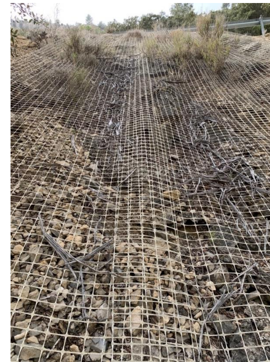
Ilustración 44 Mallazo para la hidrosiembra. Fuente: Elaboración propia.
