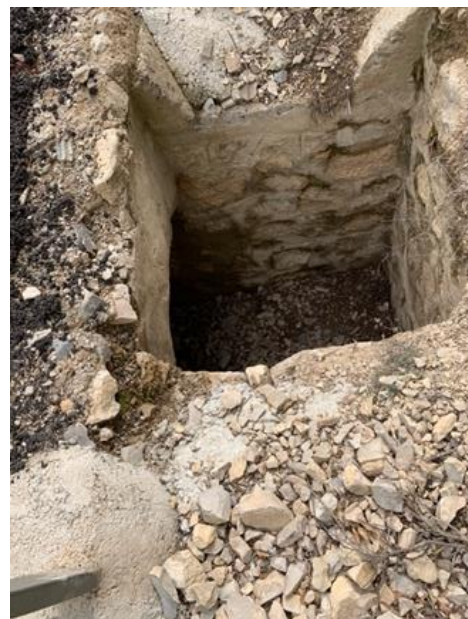
Ilustración 18 ODT de mampostería Fuente: Elaboración propia.
