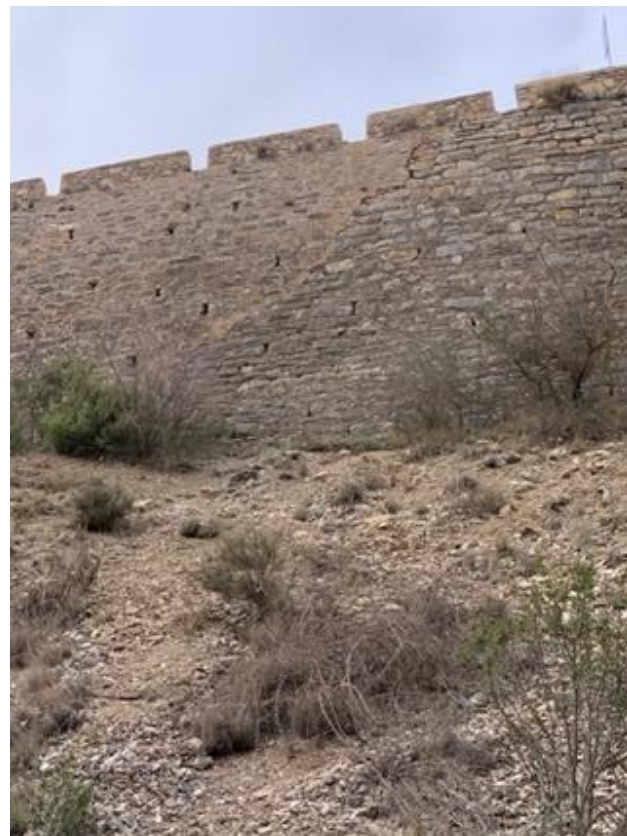
Ilustración 33 Muro de mampostería reparado. Fuente: Elaboración propia.
