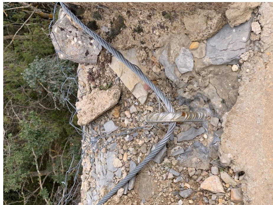
Ilustración 37 Detalle de la sujeción de la malla. Fuente: Elaboración propia.
