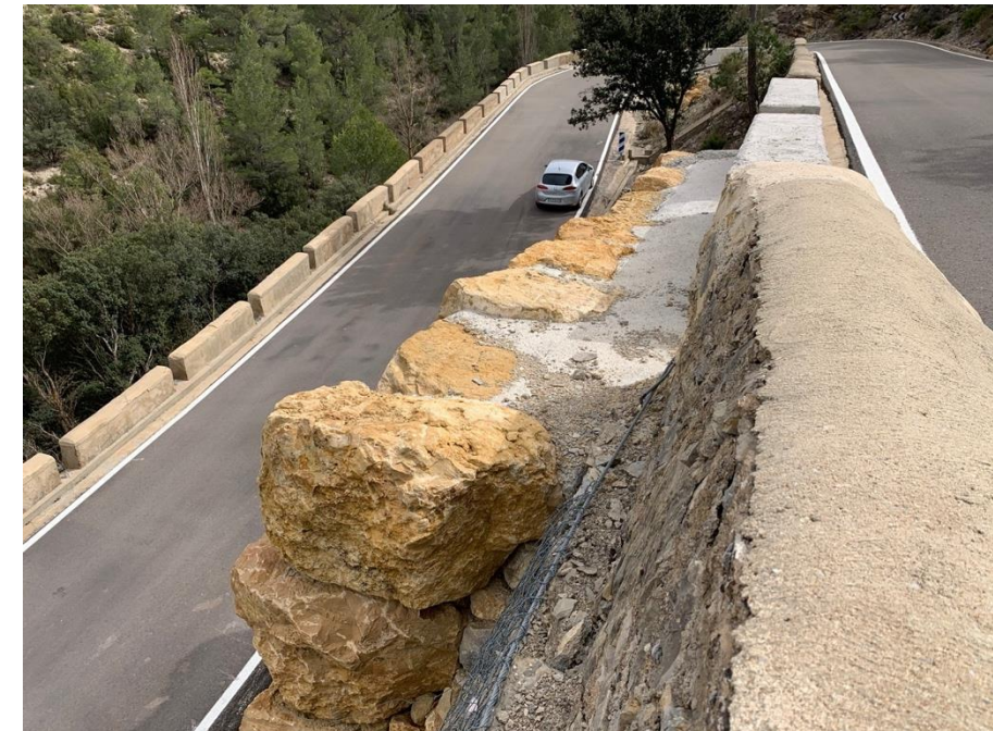
Ilustración 42 Acabado del muro de escollera. Fuente: Elaboración propia.
