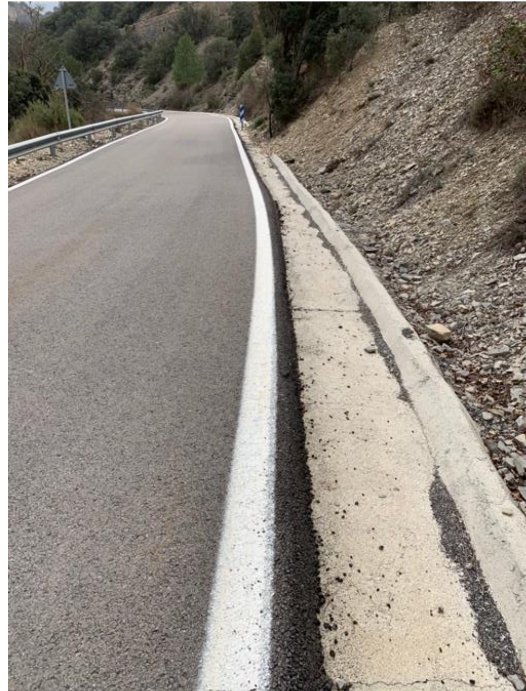
Ilustración 17 Cuneta. Fuente: Elaboración propia.
