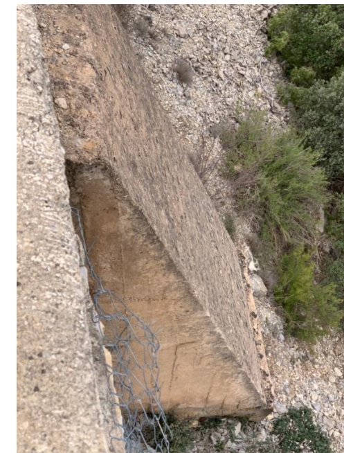
Ilustración 39 Contrafuerte. Fuente: Elaboración propia.
