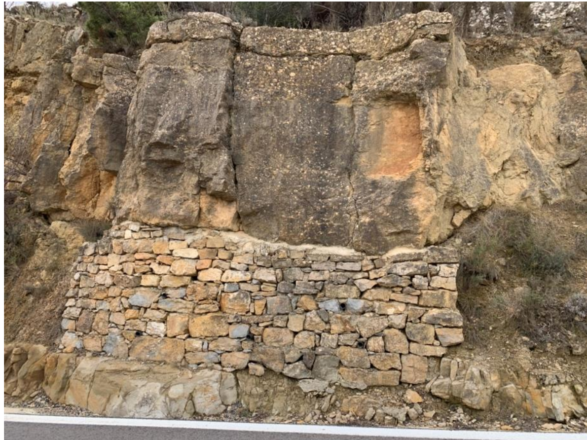
Ilustración 43 Muro de mampostería, para sostener la zona afectada por la erosión diferencial. Fuente: Elaboración propia.
