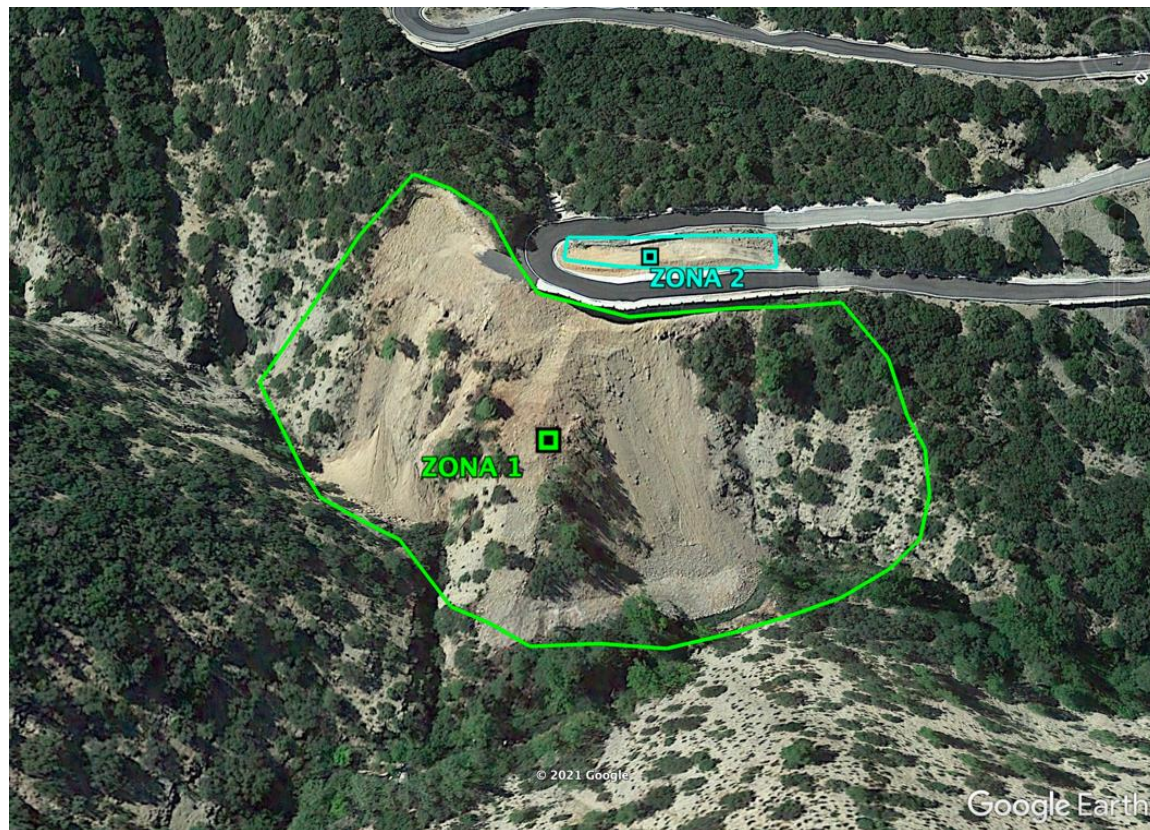
Ilustración 94 Vista aérea de las zonas a restaurar. Fuente: Google Earth.
