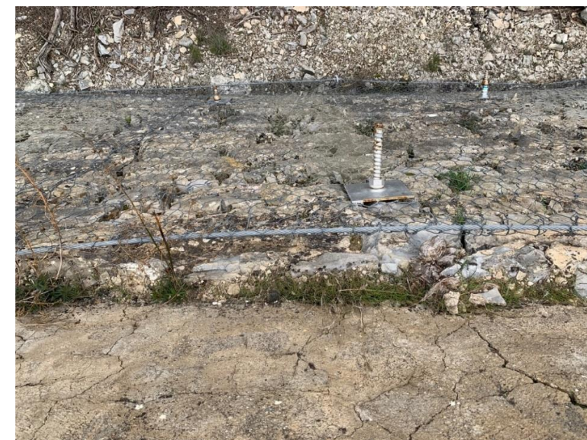
Ilustración 35 Detalle de los anclajes y la malla. Fuente: Elaboración propia.
