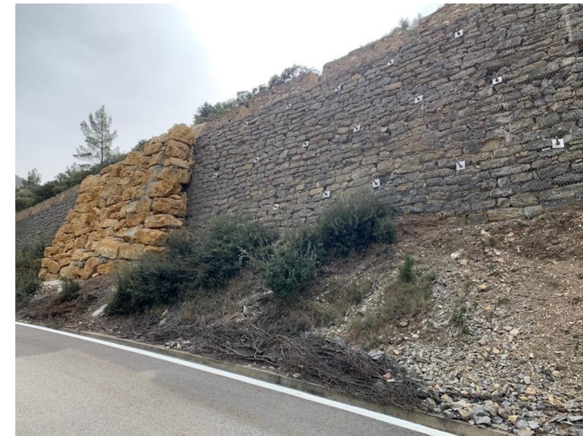
Ilustración 34 Muro de mampostería reforzado con anclajes autoperforantes y muro de escollera. Fuente: Elaboración propia.
