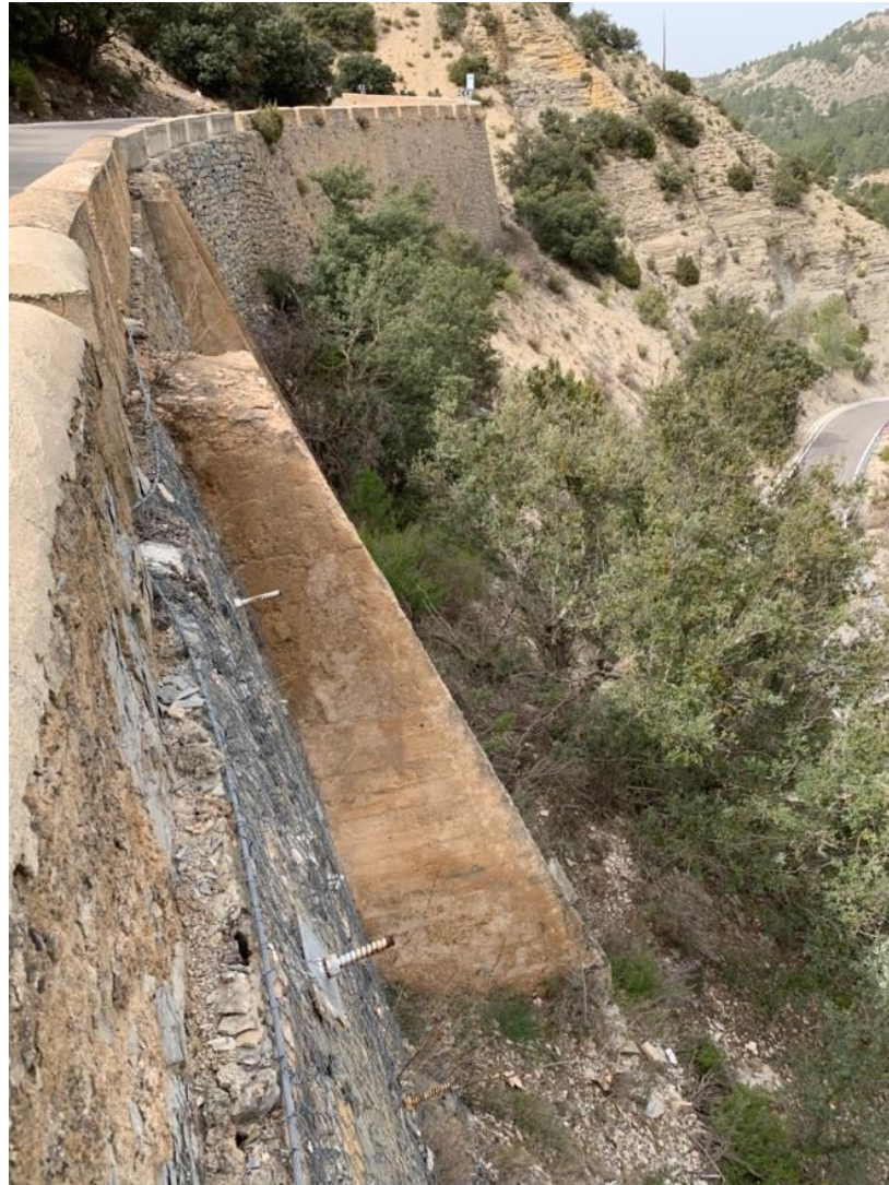
Ilustración 40 Grupo de contrafuertes. Fuente: Elaboración propia.
