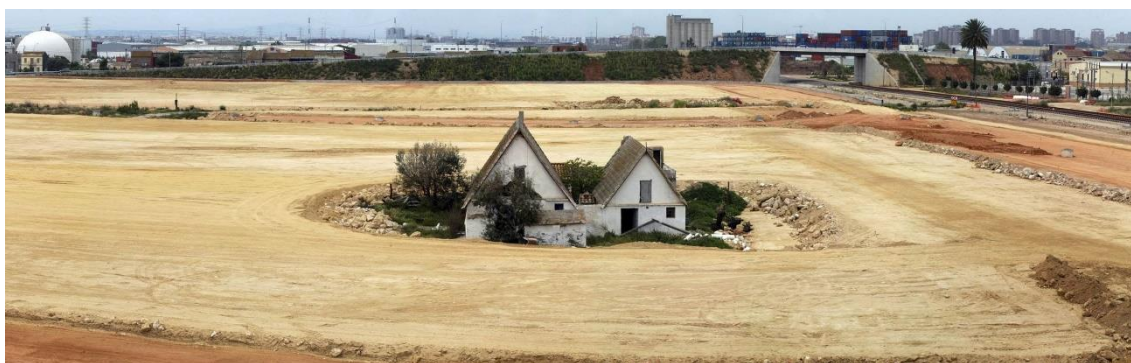
Imatge 1. Obres de la construcció de la ZAL.
