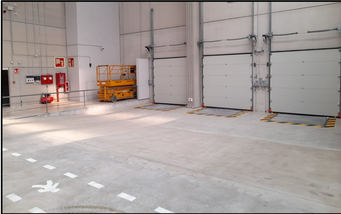
Ilustración 60: Muelles de carga y descarga integrados en la infraestructura sin acceso de vehículos al interior. Fuente: Elaboración propia.
