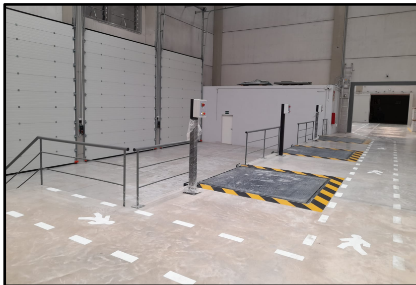
Ilustración 59: Muelles de carga y descarga integrados en la infraestructura con acceso de vehículos al interior. Fuente: Elaboración propia.
