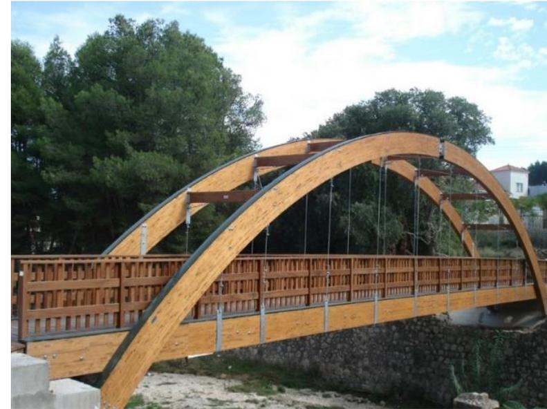
Figura 27. Puente de madera tipo arco con tablero inferior. Fuente: ruubay.com
