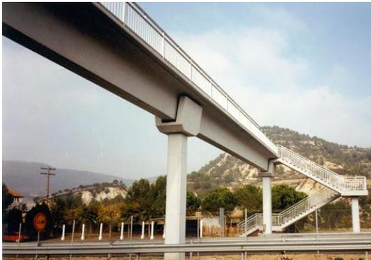
Figura 16. Pasarela prefabricada de hormigón prefabricado. Grupo Pacadar. Fuente: dobooku.com
