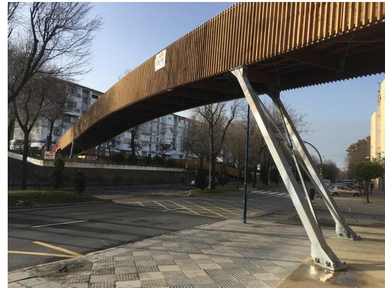
Figura 17. Puente de madera tipo viga en Huelva. Fuente: egoin.com
