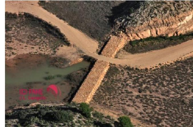
Figura 3. Vista aérea del dique de escollera existente sobre la pasarela flotante actual. Fuente: Proyecto de ejecución de pantalán flotante en el Pantano de Almansa (2014).
