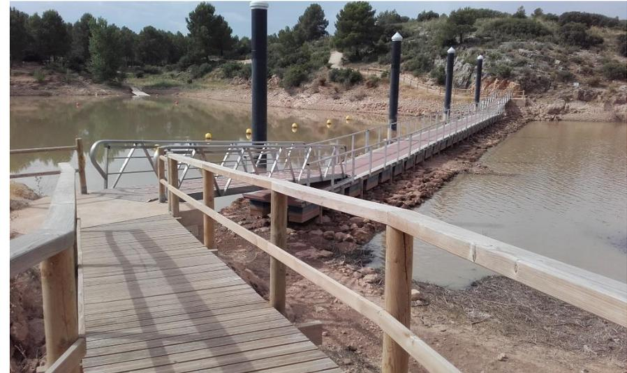
*Imagen 1. Pasarela Flotante recién construida sobre el dique existente. Fuente: Técnico de Medio Ambiente del Excmo. Ayto. de Almansa (2014).*
