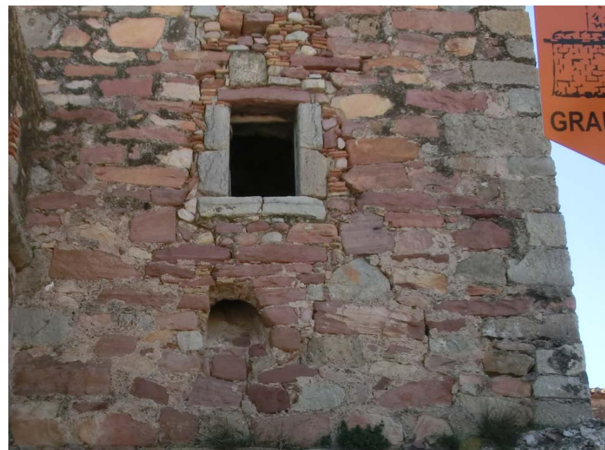
Ampliación primera planta del muro norte de la torre del Grao Vell.
