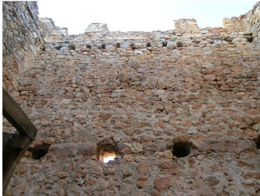
Muro interior oeste donde se observan los huecos para las vigas de madera.
