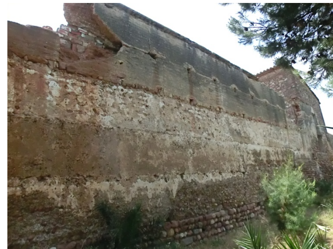
Muro oeste por su parte exterior, donde se ve los diferentes tapiales.
