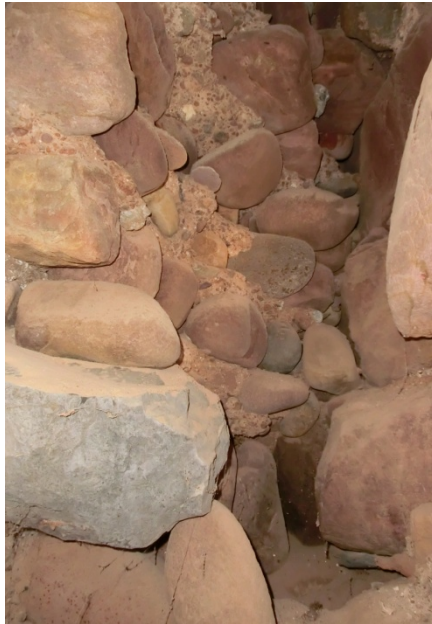
Interior muro donde se ven los cantos de terrapieno.
