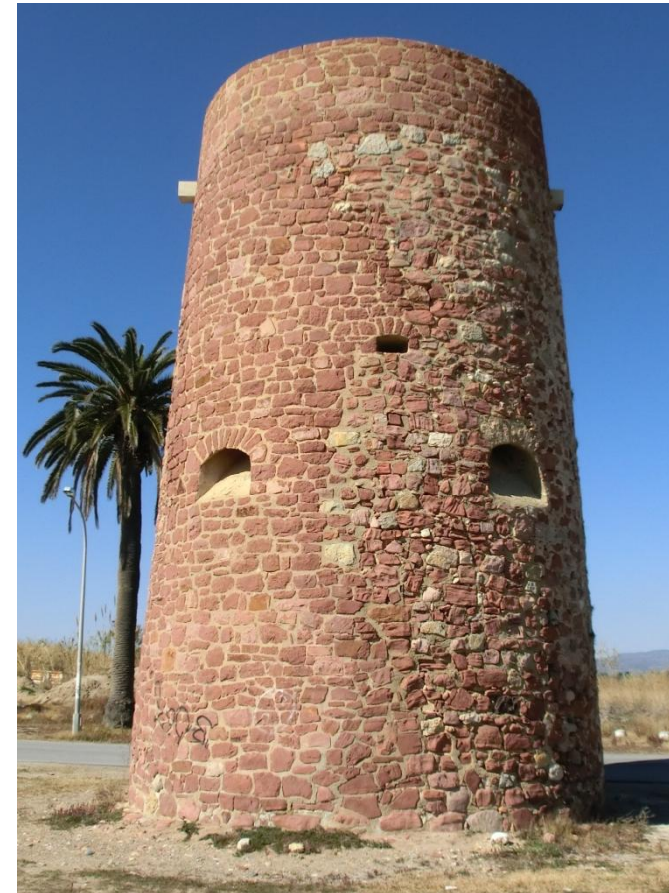
Foto de la torre del Puig donde se diferencia la parte del muro totalmente restaurado y la parte de muro afianzado
