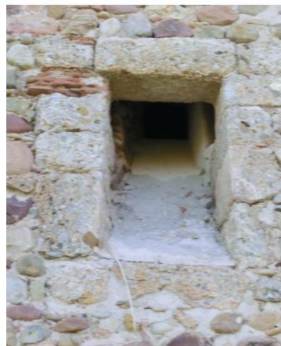
Detalle tronera con derrame oblicuo.
