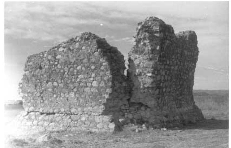
Foto de la torre de Biesma en 1979, donde se ve los muros con desplome hacia el exterior. Fuente: http://homepage.ntlworld.com/forcada/
