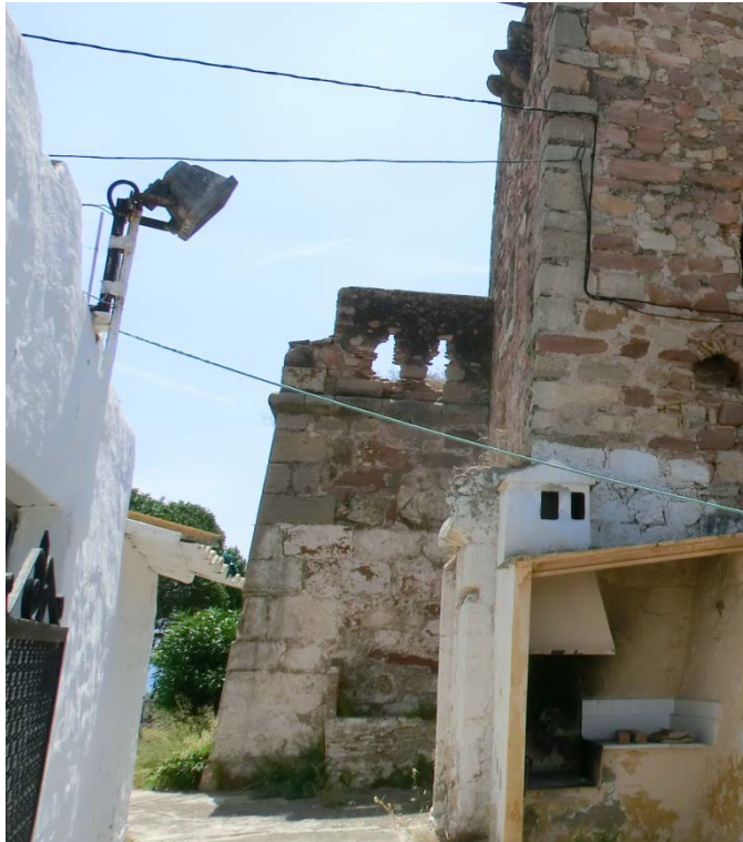
Bateria del Grau Vell, donde se ve el murete con aspilleras para la protección de la entrada al cercado.
