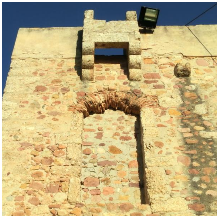
Detalle de puerta de acceso tapiada de primera planta, matacán y gárgola.
