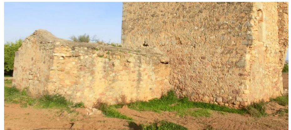
Estancia adosada a la torre de Roc.
