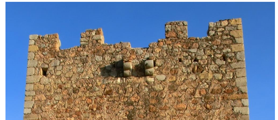
Detalle de la terraza del muro oeste con los restos del matacán.
