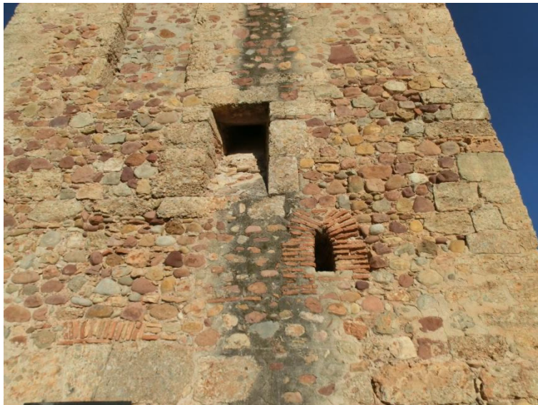
Torre de Borriana, donde se observa la utilización de cantos rodados, sillería y ladrillo.
