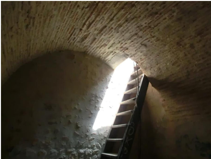
Detalle de la bóveda de cañón de la terraza.
