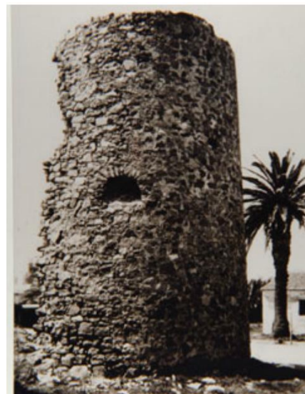
Antigua foto de la torre de Guaita del Puig, donde se observa parte del muro derrumbado. 61
