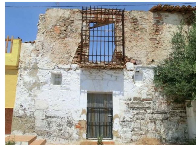
Zona del almacén de dos pisos.
