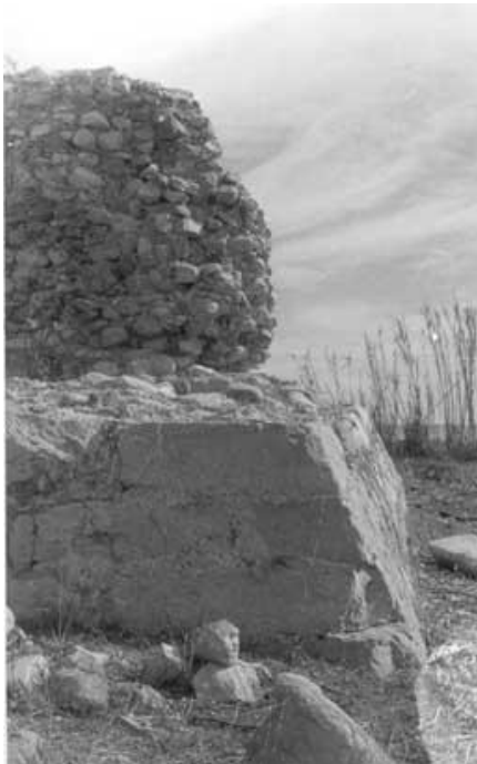
Foto de la torre de Biesma en 1979, donde se ve la base en talud. Fuente: http://homepage.ntlworld.com/forcada/
