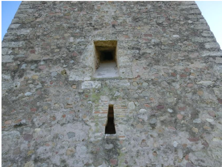
Torre de Borriana donde se puede ver una tronera y una ventana de planta baja
