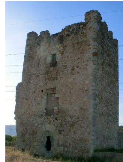
Detalle de la terraza del muro este con el matacán y las gárgolas.
