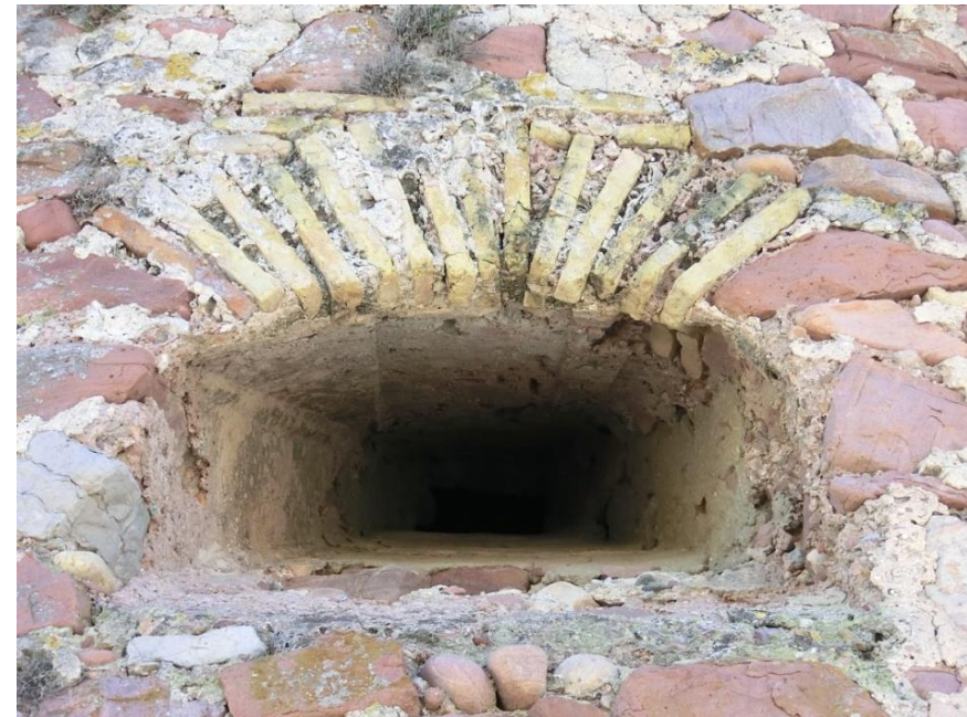
Detalle de tronera con arco de ladrillo.
