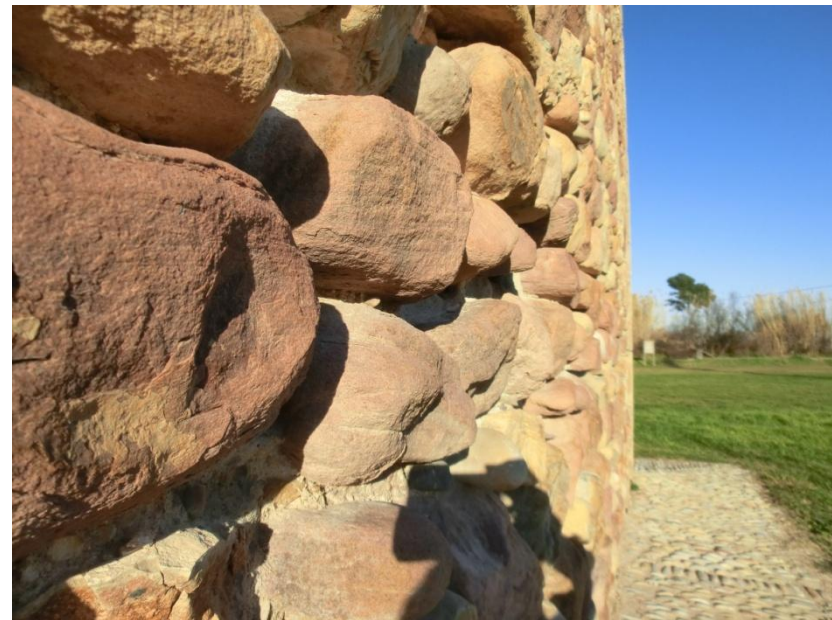
Detalle de cantos rodados con mortero de cal.
