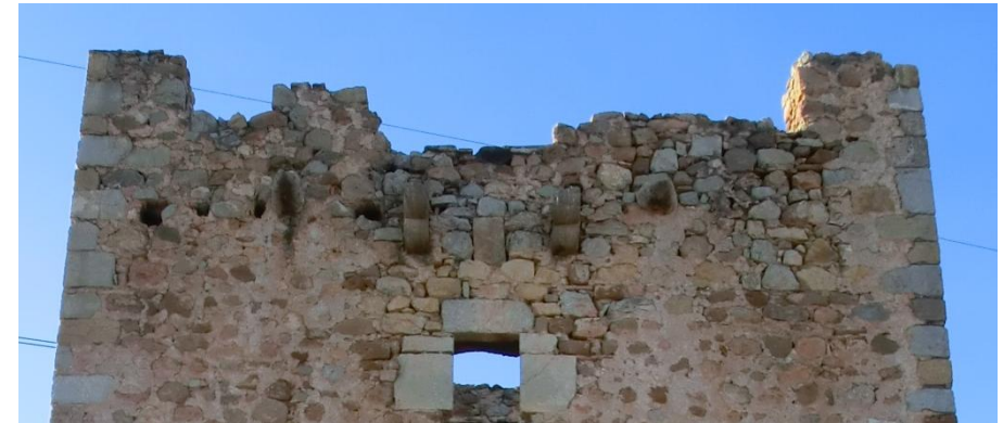
Detalle de la terraza del muro este con el matacán y las gárgolas.
