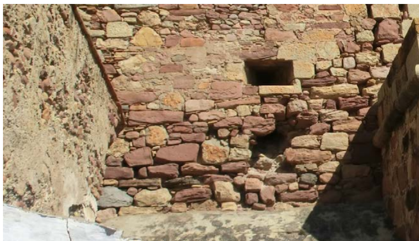
Ampliación primera planta del muro sur de la torre del Grao Vell.
