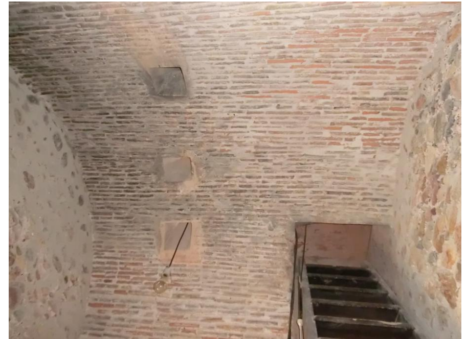
Interior de la Torre de Borriana donde se puede ver la bóveda de cañón de primera planta con el hueco de acceso y las buheras.
