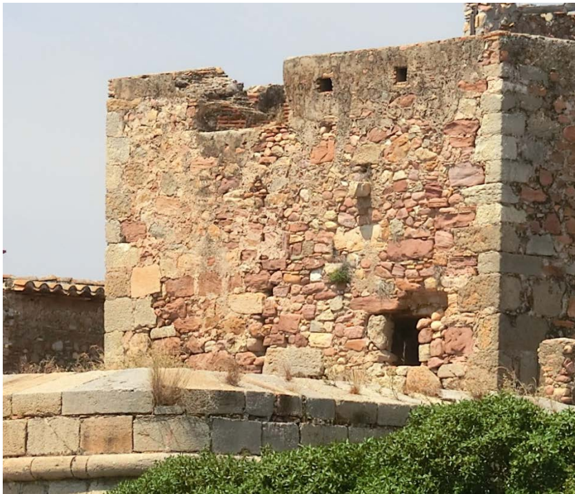
Ampliación de primera planta del muro este de la torre del Grao Vell.
