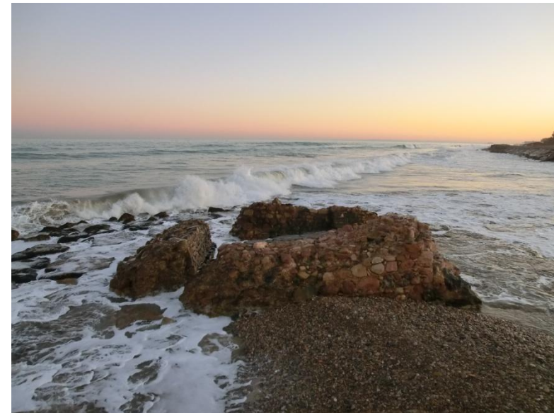
Estado actual de la torre de Biesma.
