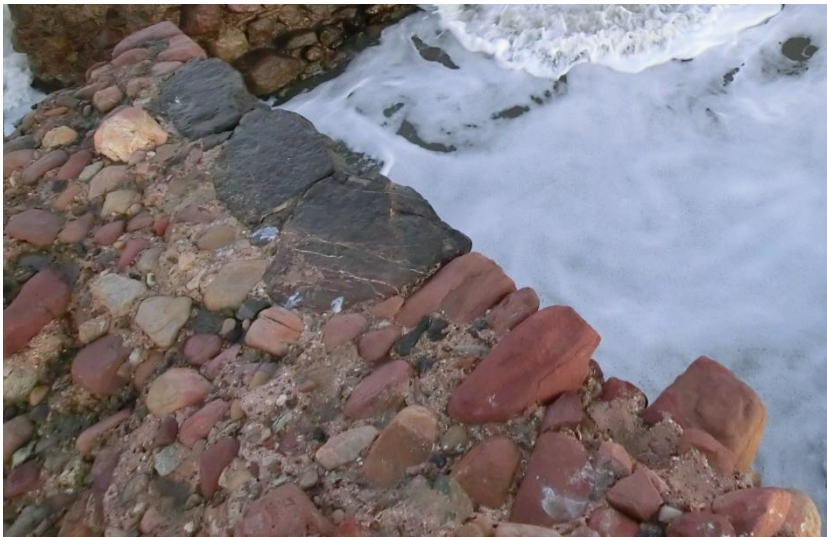
Foto actual donde se observa los cantos de río y el mortero de cal con arena y grava con un característico color rosáceo.
