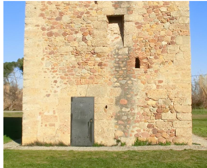
Acceso adintelado y ventana de planta baja y tronera de primera planta
