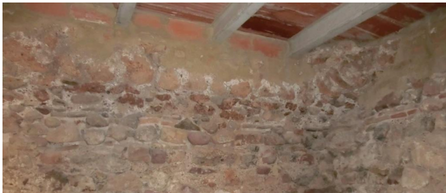
Arranques de la bóveda de cañón de cubierta de planta baja.
