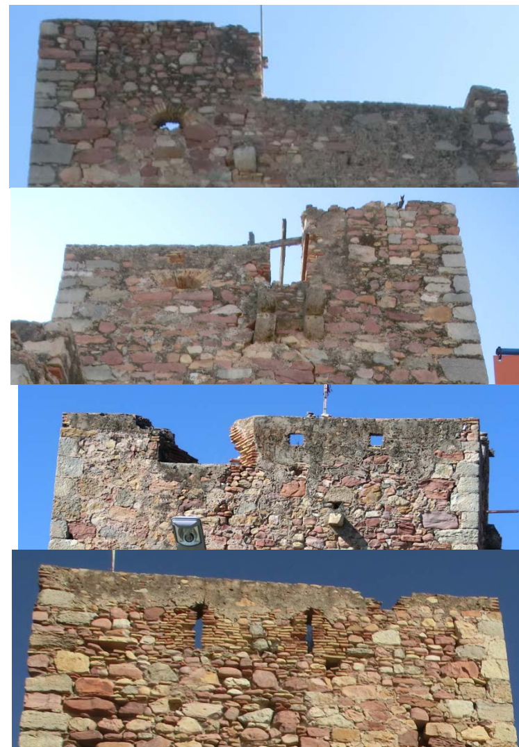
Ampliación de los muros de terraza, oeste, norte, este, sur respectivamente.
