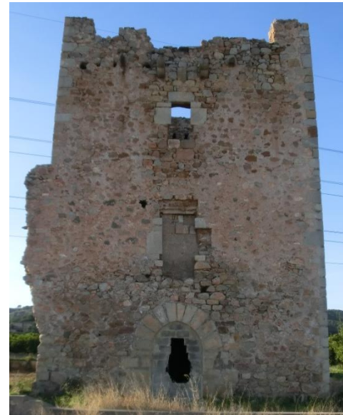
Fachada este donde están los tres huecos y el resto del muro del edificio anexo.
