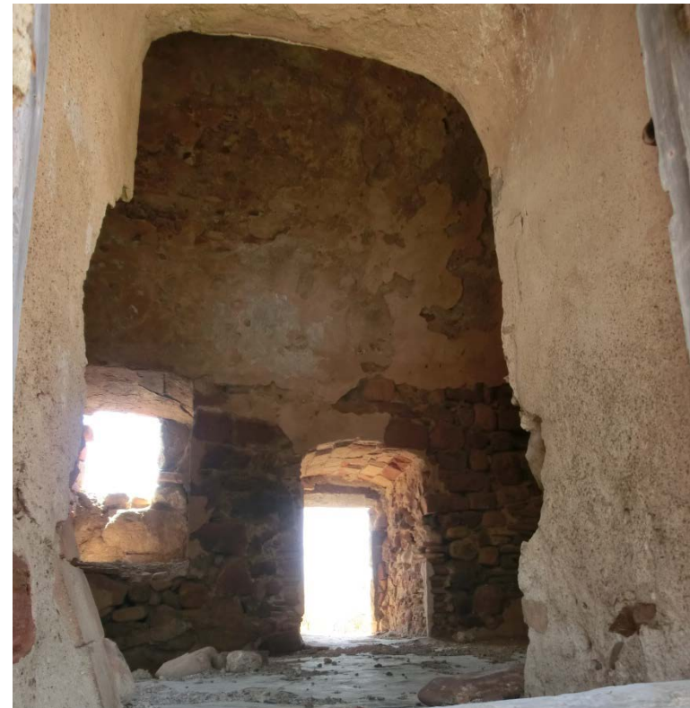
Vista del interior de la primera planta de la torre.
