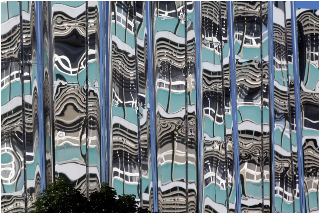
Fig. 389. Patterson Associates Architects . Museo Len Lye: Len Lye Centre . Ciudad de New Plymouth, en la isla norte de Nueva Zelanda. Fachada del museo (detalle). Espejos curvos alabeados y paneles de acero inoxidable. Sentido móvil del espacio, distorsión óptica al reflejar la arquitectura se crean ecos visuales, reverberaciones más irregulares y formas orgánicas, eliminando el carácter rectilíneo.
