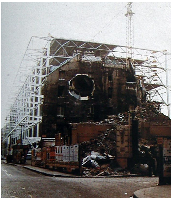
80. Gordon Matta-Clark. Intersección cónica , 1975. Fotografía en color. Contemplar de la exterioridad a la interioridad.
