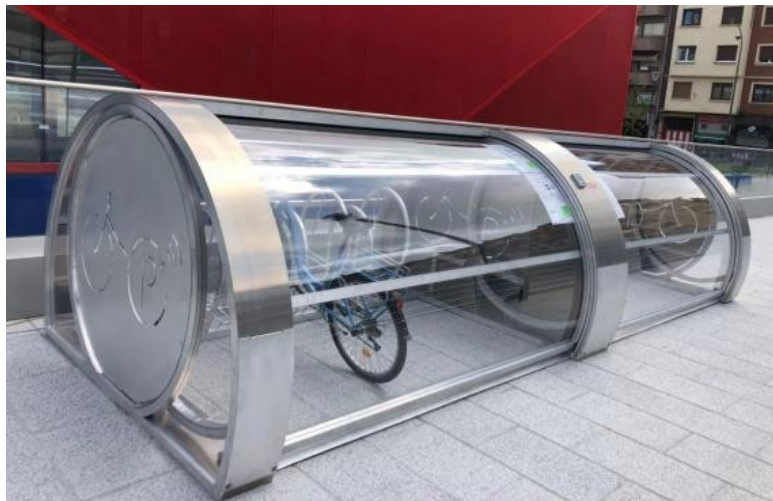
Imagen 16. Aparcamiento para bicicletas cubierto. (Fuente: santander.es, 2021)
