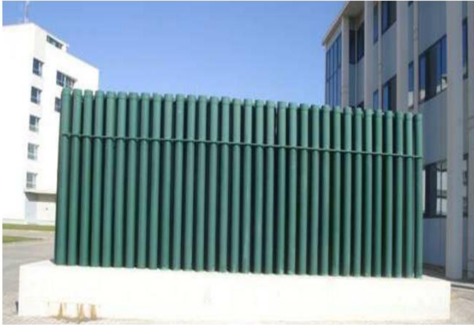
Figura 4. Pantalla acústica compuesta por dispersores aislados situada en el campus de Vera (UPV) [8].
