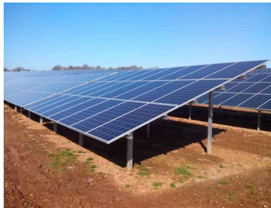
Figura 14. Soporte fijo para módulos solares. Fuente: *Nclave, S.L.*
