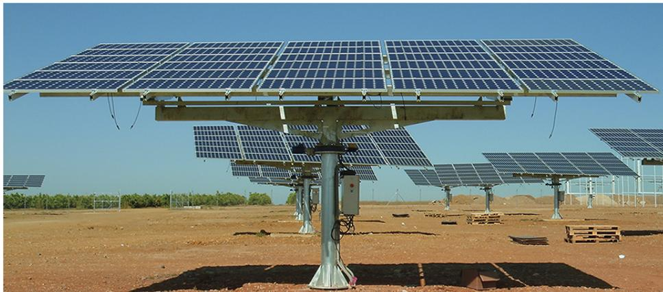
Figura 15. Soporte móvil para módulos solares. Fuente: Eleton.
