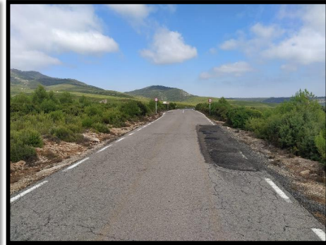
Ilustración 8: Aproximación a curva tras acuerdo vertical. Fuente: Elaboración propia.
