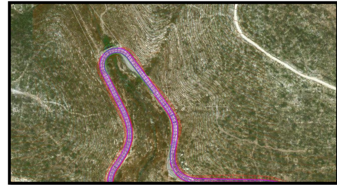
Ilustración 4: Trazado existente sobre estructura en barranco. Fuente: Elaboración propia.
