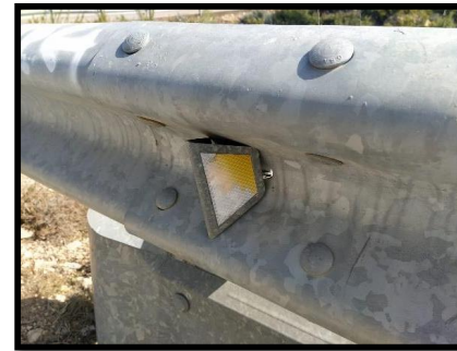
Ilustración 24: Estado actual de capta faros. Fuente: Elaboración propia.
