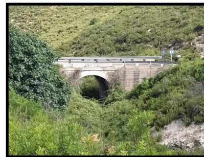
Ilustración 4: Estructura sobre barranco del fraile.
