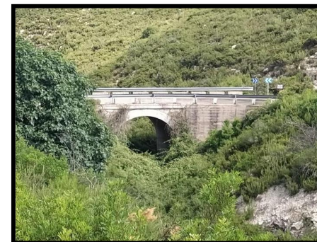
Ilustración 6: Estructura sobre barranco del fraile. Fuente: Elaboración propia.
