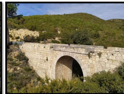
Ilustración 5: Estructura sobre barranco de la cierva.
