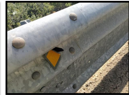
Ilustración 19: Estado actual de capta faros. Fuente: Elaboración propia.
