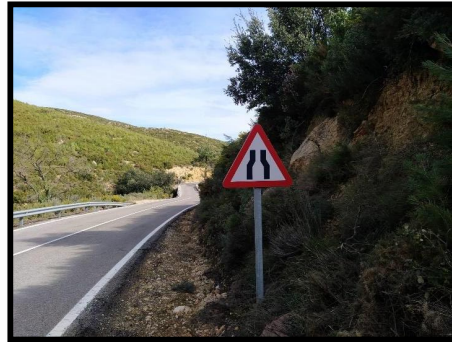
Ilustración 14: Señalización de estrechamiento. Fuente: Elaboración propia.
