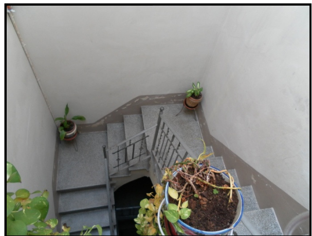
Pavimento de terrazo continuo en toda la escalera
