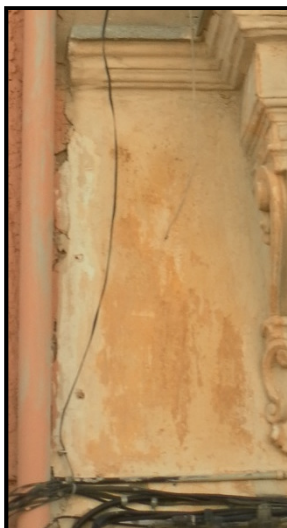
Mancha debida a los restos de algún adhesivo
