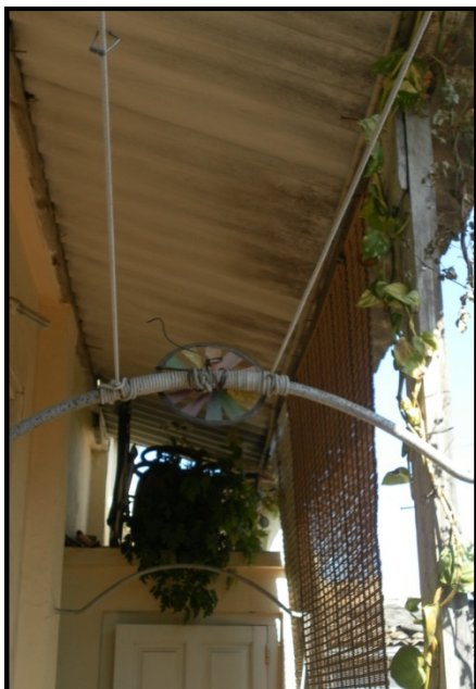
Ensuciamiento de la cubierta de fibrocemento de la galería
