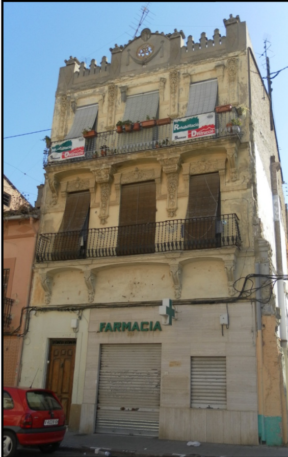
Fachada de la calle Escalante, 192 (actual 206)
