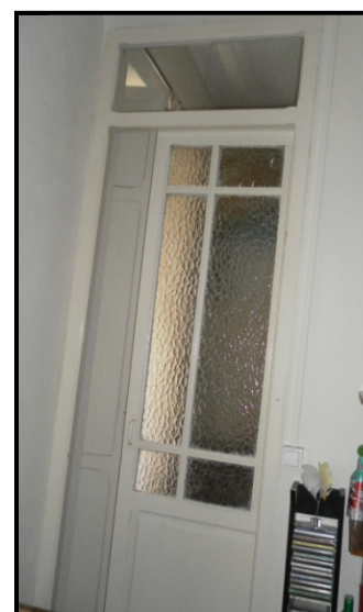
Puerta corredera del despacho
