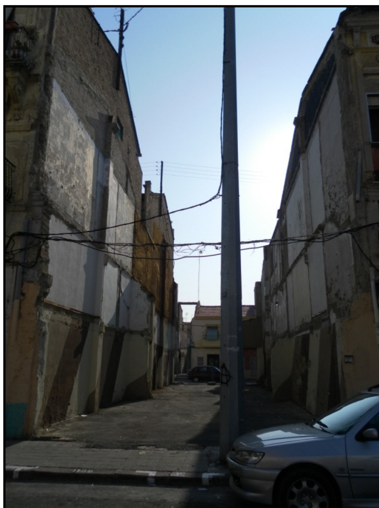
Solar que está en la medianera del edificio
