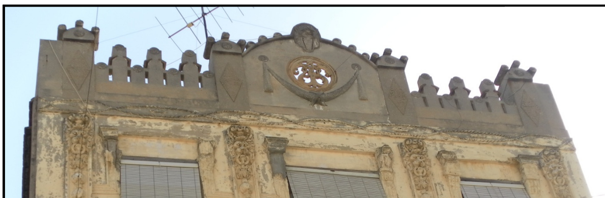
Peto creado para ocultar el faldón de la cubierta
