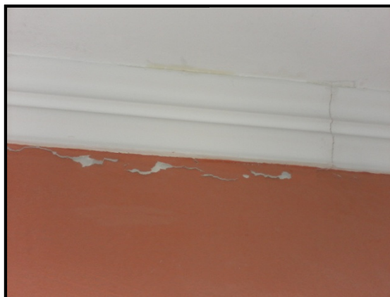
Desprendimientos en bajo la ventana del dormitorio principal y en la pared de la sala de estar
