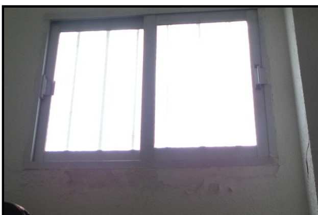
Desprendimientos en bajo la ventana del dormitorio principal y en la pared de la sala de estar
