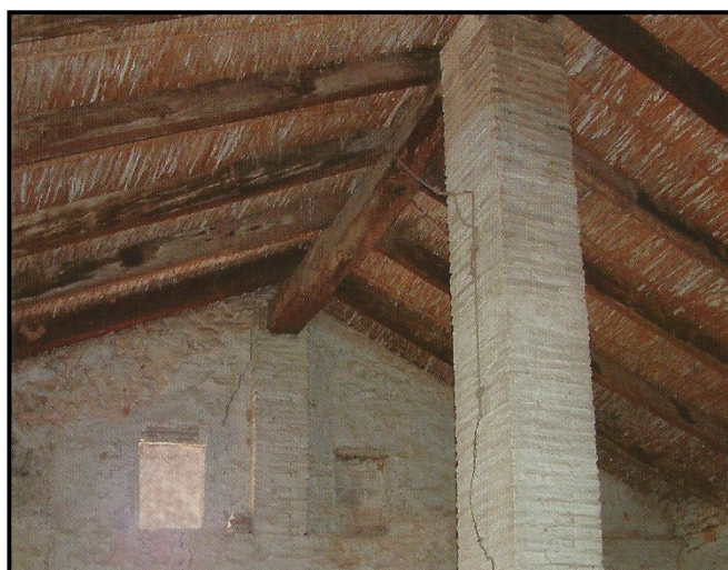
Ejemplo de pilares de ladrillo en una cubierta con encuentro de vigas
