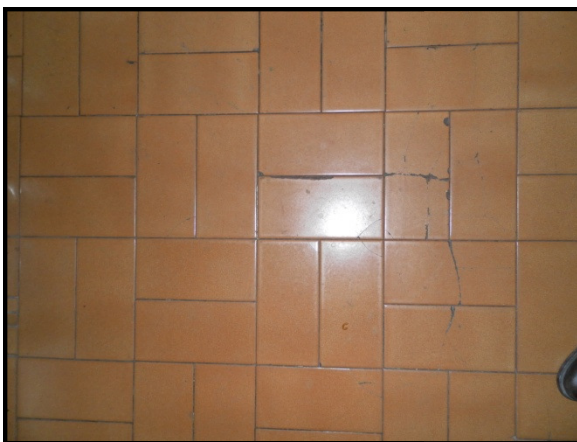
Pavimento de la cocina
