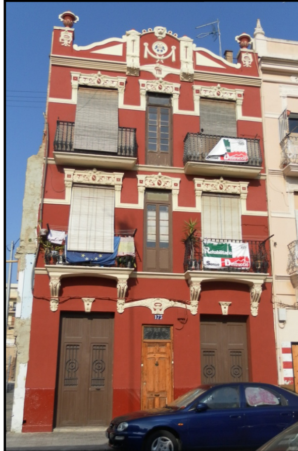
Fachada de la calle José Benlliure, 183 (actual 173)
