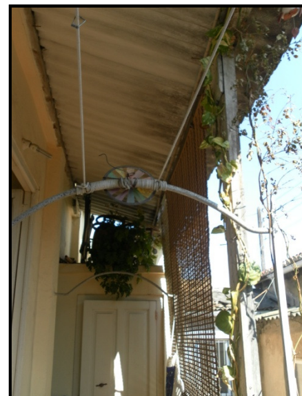
Vista de las soportes de la cubierta
