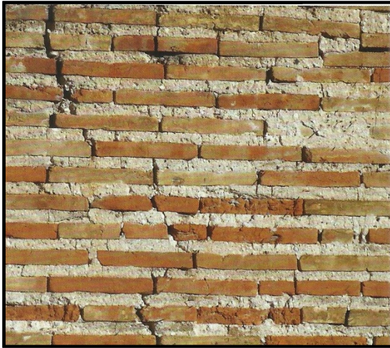
Fachada de ladrillo
