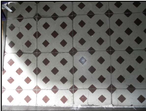
Pavimento de baldosines hidráulicos del dormitorio principal
