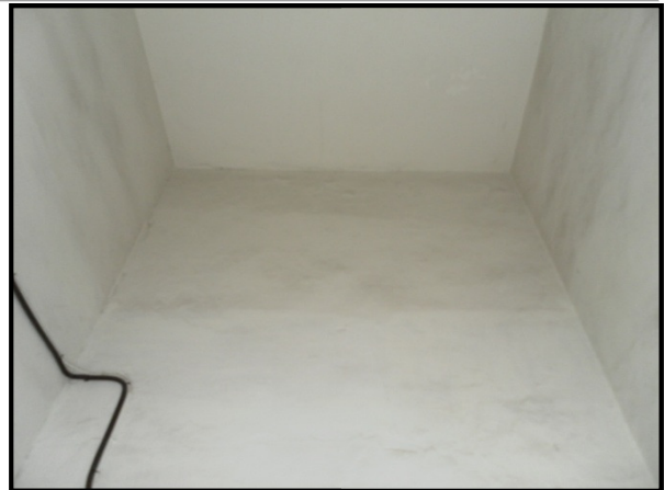
Sombras de polvo en el patio debido a las irregularidades
