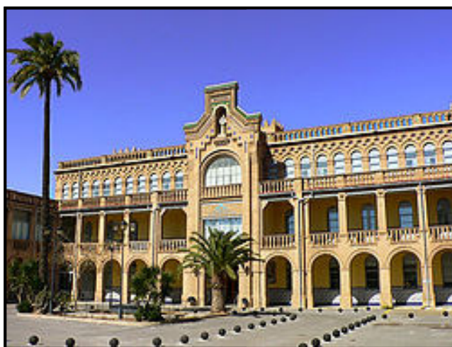
Actual estado del Asilo San Juan de Dios
