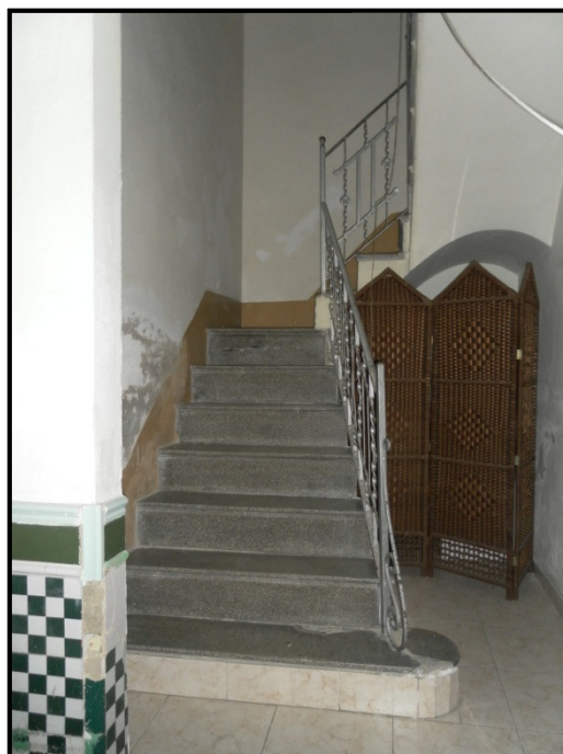
Escalera tabicada del edificio
