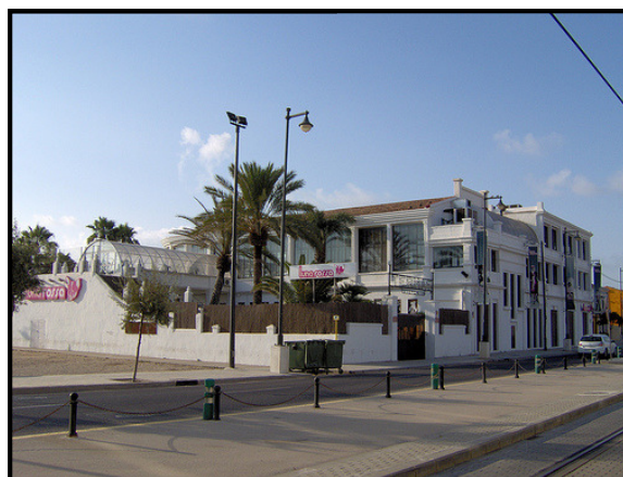
Reforma de las termas en la actual discoteca Akuarela
