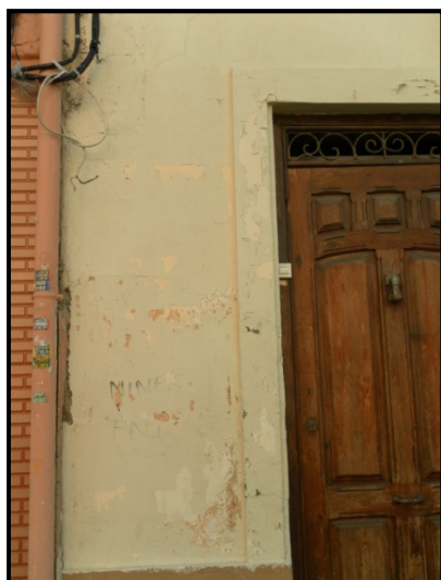
Desconchados de pintura en la planta baja
