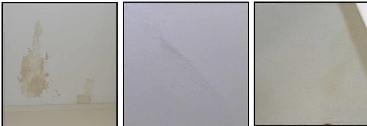
Humedades de pequeña entidad en la zona de la entrada, del comedor y del dormitorio
