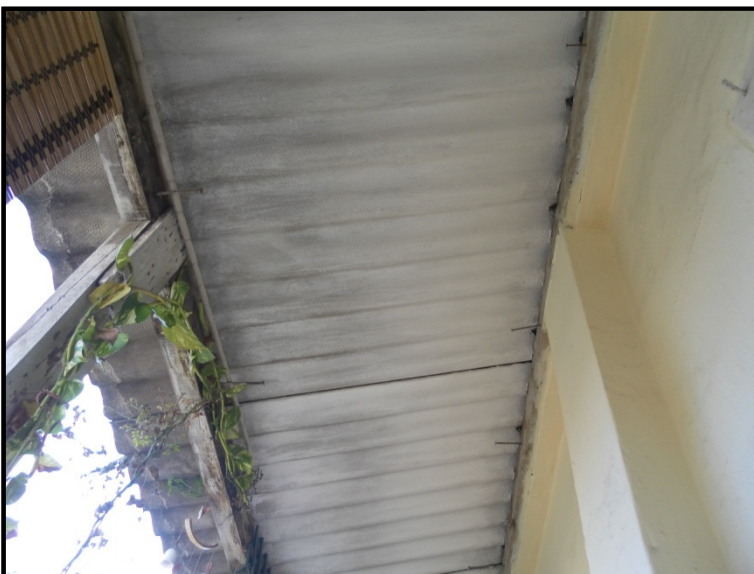
Vista de la cubierta de fibrocemento
