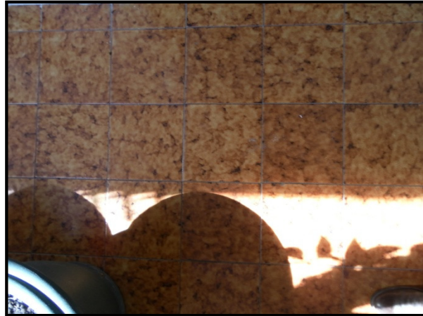
Pavimento de gres de la galería
