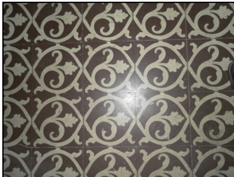
Pavimento de baldosines hidráulicos del despacho
