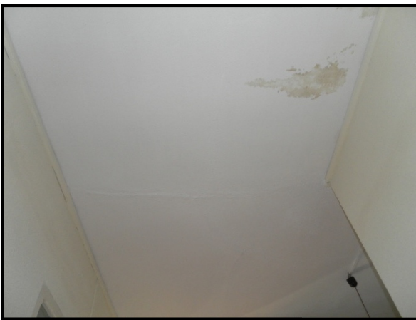
Cielorraso de la vivienda
