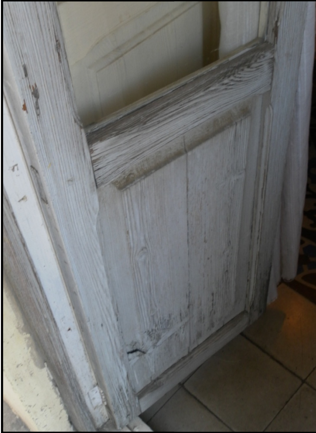
Desgaste de la madera debido a los agentes climatológicos
