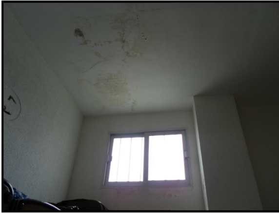
Ventana del dormitorio principal
