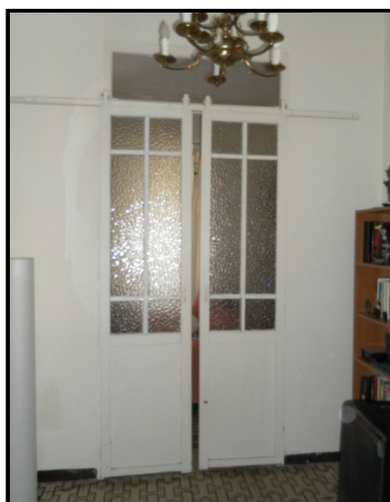
Puertas correderas del comedor
