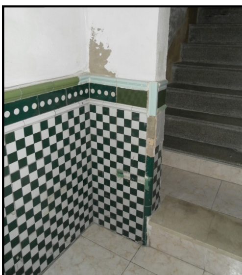
Revestimiento del portal
