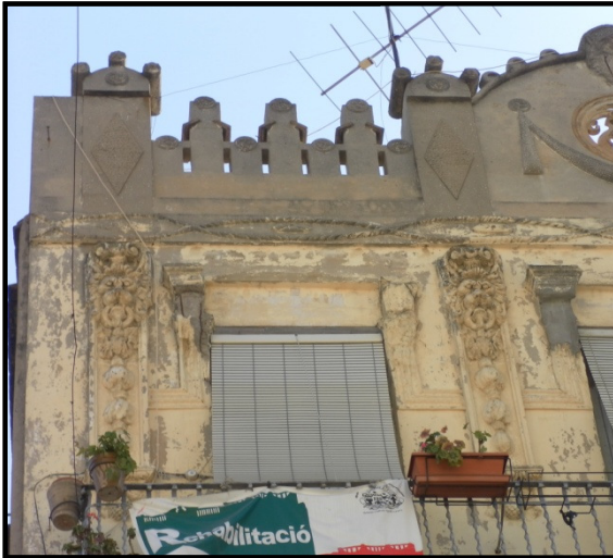
Fachada calle Escalante
