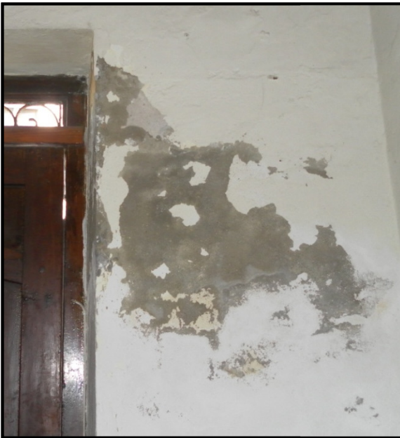
Humedades con desconchamientos y exfoliaciones en la entrada del edificio
