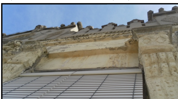
Grietas de los desprendimientos vistos desde el balcón
