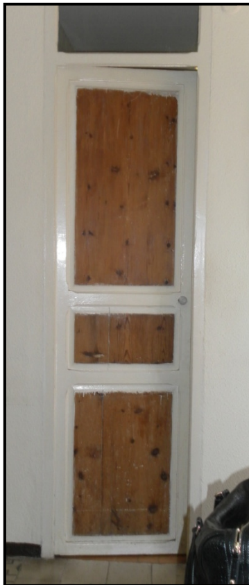
Puerta de la cocina
