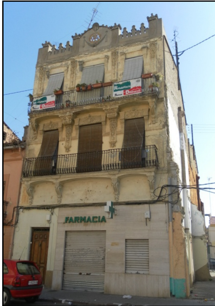
Fachada del edificio
