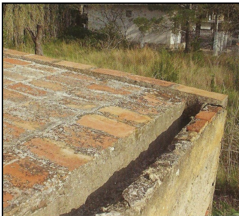
Ejemplo de canal integrado en un muro
