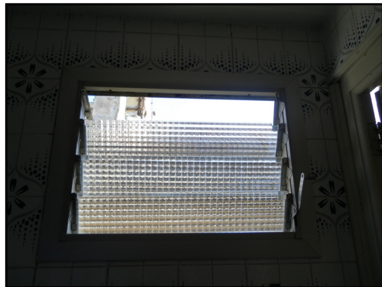
Ventana del baño
