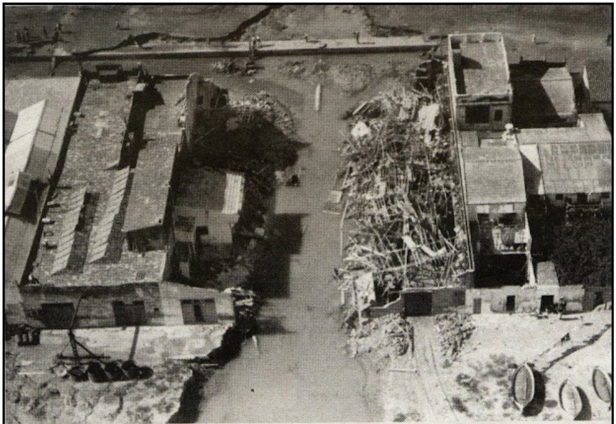
Destrucción de las travesías debido a la fuerza de la agua
