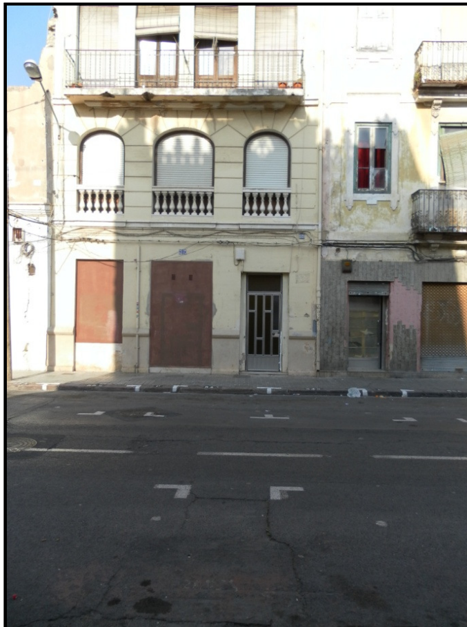
Vista desde la salida del edificio
