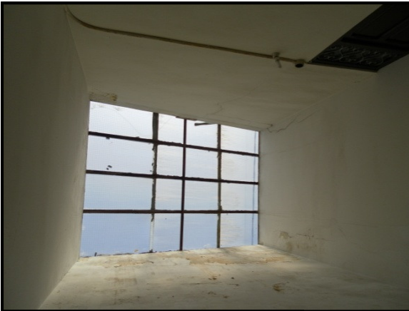
Vista de la claraboya desde la escalera
