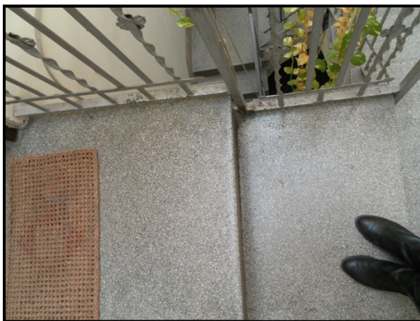
Pavimento de terrazo continuo
