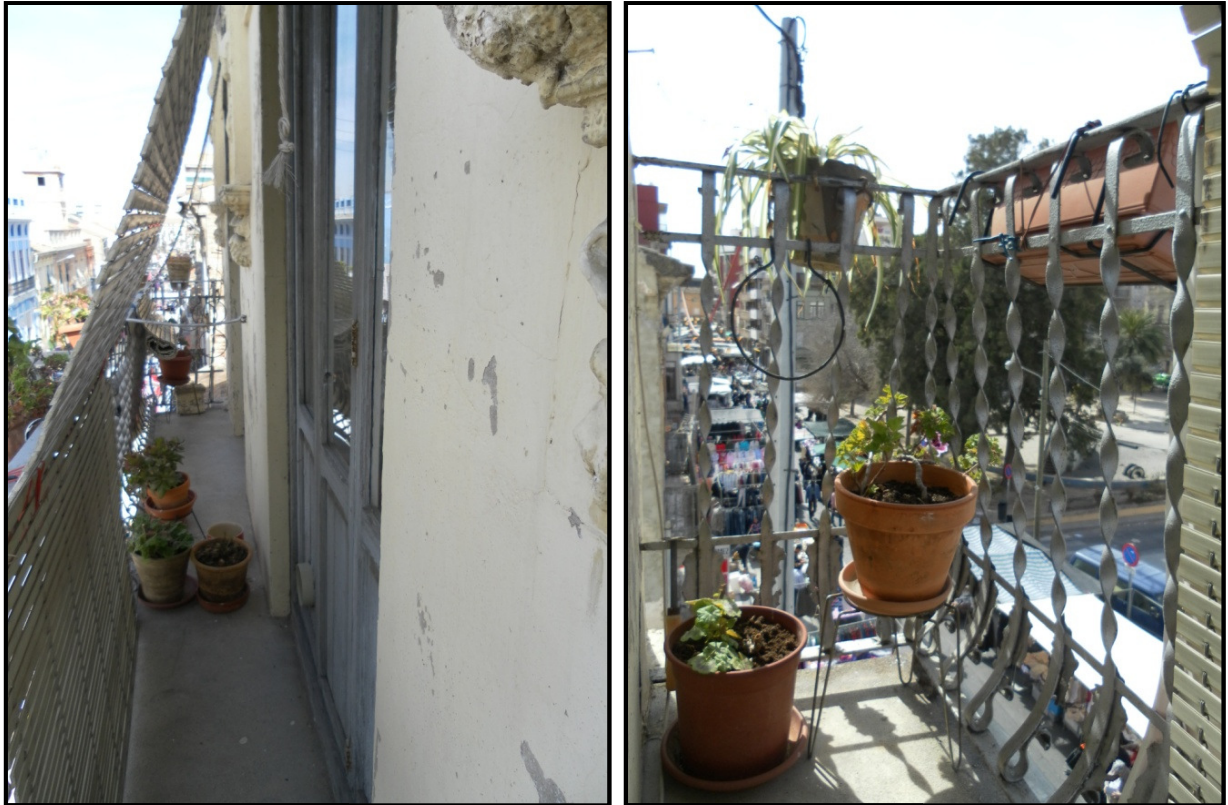
Pavimento de mortero de cemento del balcón principal
