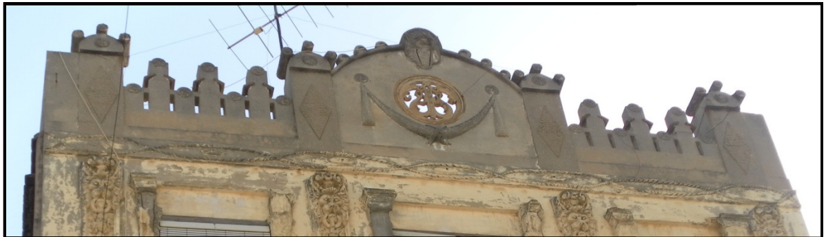
Fachada de la calle Escalante
