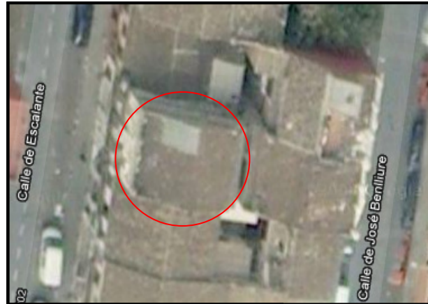
Vista aérea del edificio y de la claraboya
