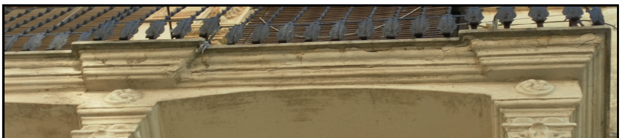
Pequeñas fisuras localizadas en los forjados de los balcones y en los cantos
