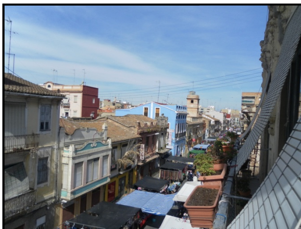
Vista desde el balcón de la segunda planta hacia el Norte
