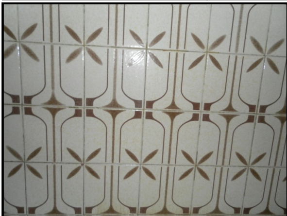
Azulejos de la cocina
