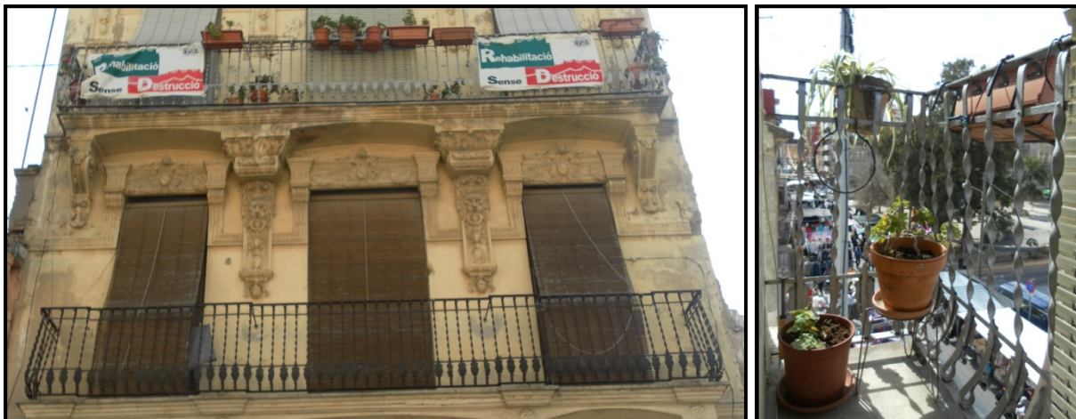
Barandillas de la primera planta y de la segunda
