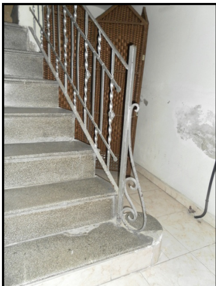
Inicio de la barandilla
