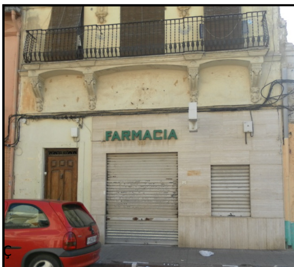
Fachada calle Escalante
