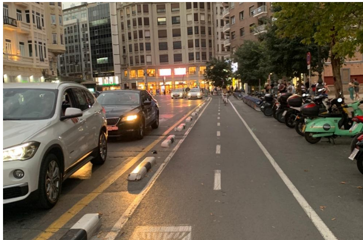
Figura 27 Tipología de carril bici segregado sobre calzada con bordillos discontinuos como elemento de protección. Fuente: Elaboración propia.
