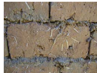
Figura 1.5 LADRILLO DE ADOBE REFORZADO CON PAJA
