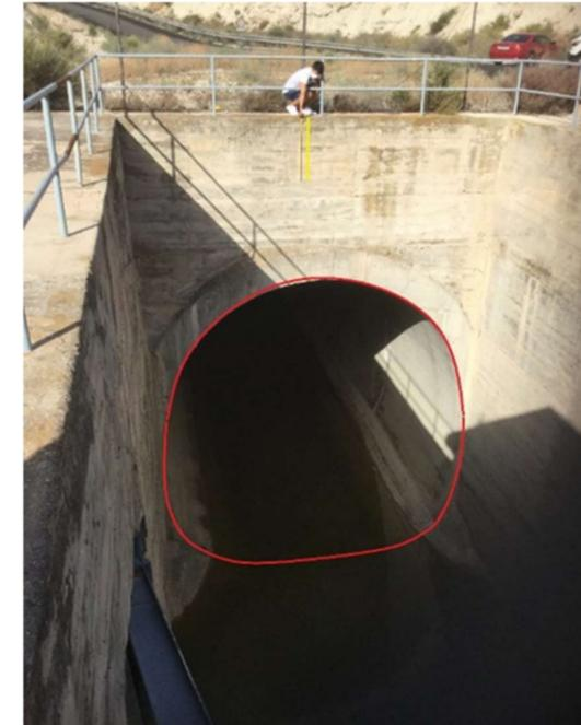
Figura 1.2.2.5. Sección túnel de captación en pie de azud (Fuente: elaboración propia, 2020)
