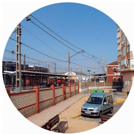
4. Estretament espacial entre les edificacions i la tanca de les vies del tren. Baixa qualitat urbanística. Paisatge poc atractiu. Carència d'ombres.
