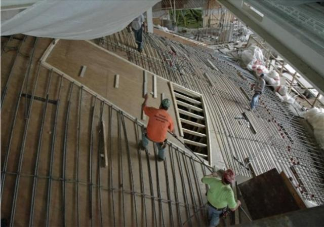
FIG.3.02. Encofrado cúpula hormigón
