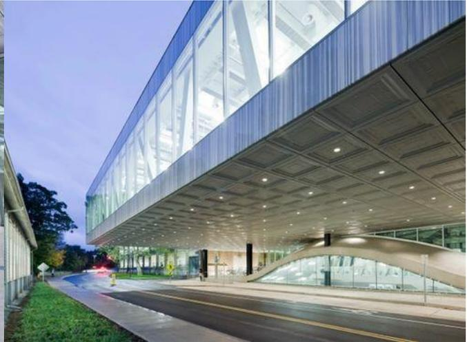
FIG.3.09. Encuentro del muro cortina con la cúpula de hormigón
