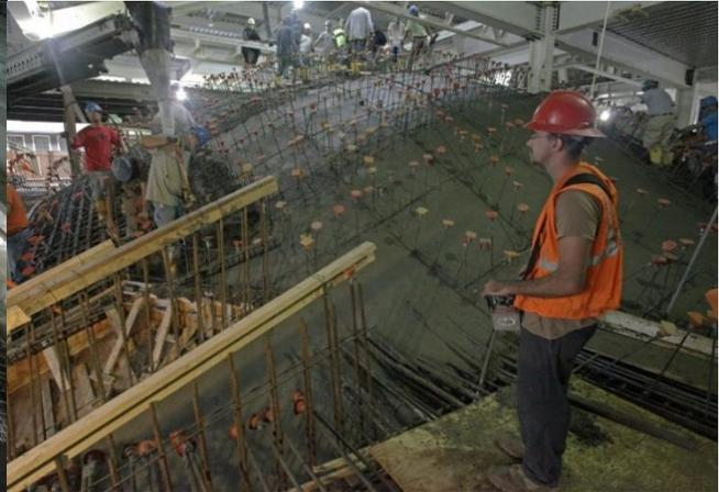
FIG.3.03. Vertido hormigón in situ
