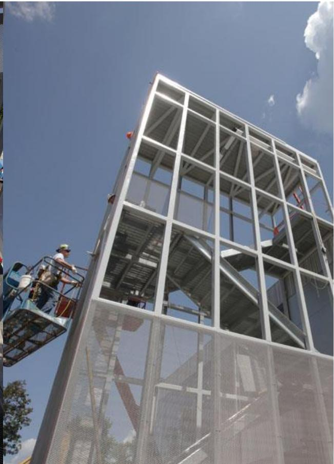
FIG.3.25. Escalera de emergencia. Paneles microperforados
