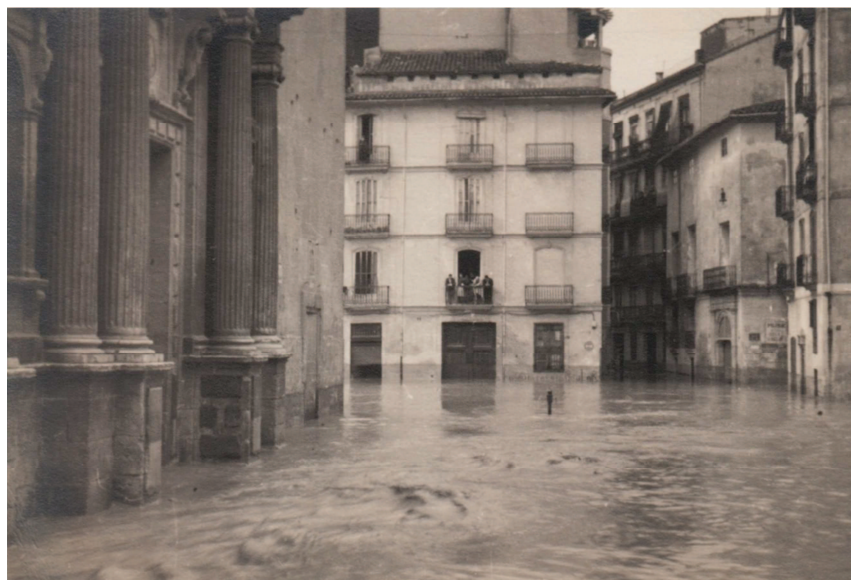
Imagen nº 91. Plaza del Carmen anegada de agua (1957).
