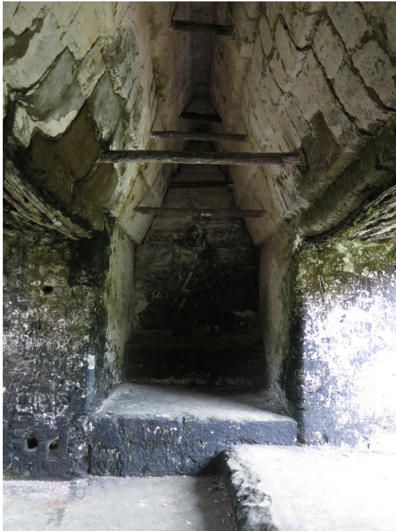
Figura 9. Interior del Edificio 5D-91 del Grupo de Siete Templos de Tikal, donde se han conservado los dinteles originales de rollizos de madera. Laura Gilabert, 2015.
