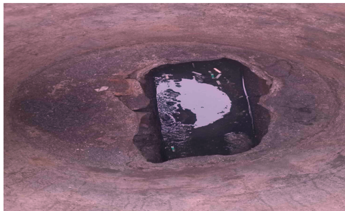
Figura 19. Colector de hormigón de línea de residuales, pozo 7177
