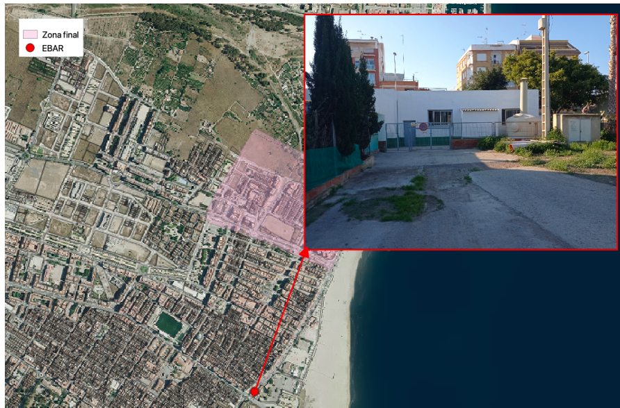
Figura 24. Situación de la EBAR del Puerto de Sagunto en la Avenida del Mediterráneo
