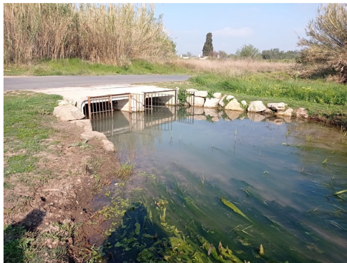
Figura 26. Aliviadero colector de pluviales de la zona de estudio en Sagunto. Foto realizada 25/03/2021
