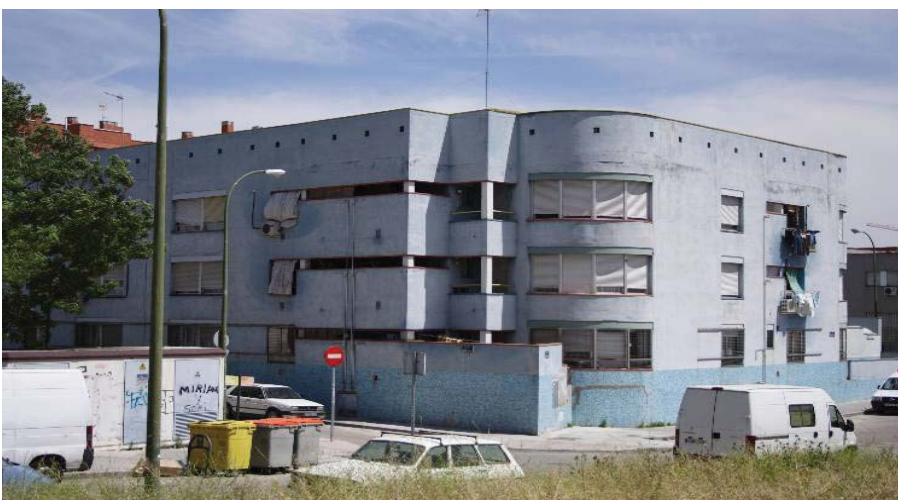
Ref. 4.45. Vista de los bloques de viviendas
