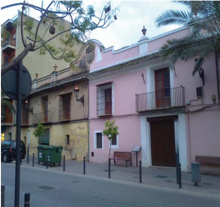
Ref.3.41. Fachada sin rehabilitar-fachada rehabilitada
