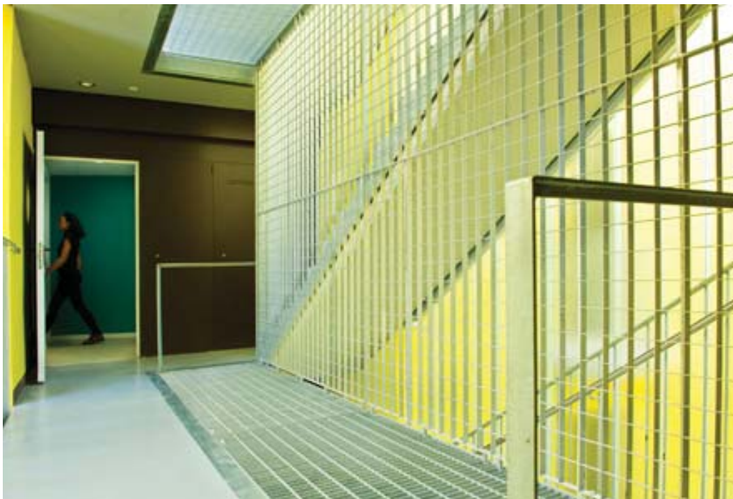
Ref.5.37. Edificio de viviendas de Hevia Meyer y Ángela Moragues, Lérida, Europan 7
