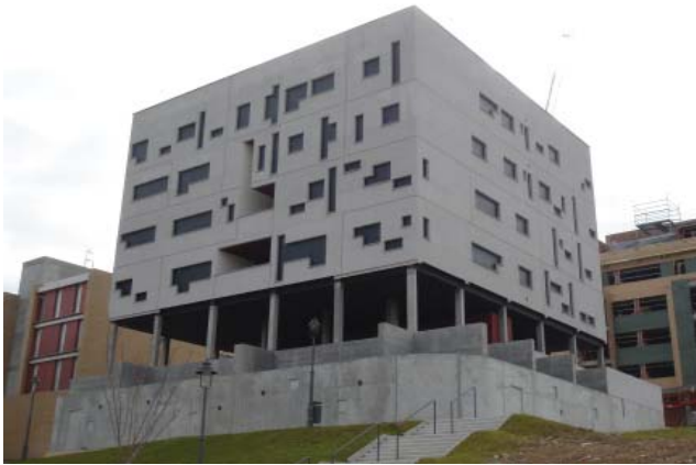
Ref.4.174. Vista del conjunto
