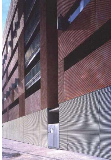
Ref.4.118. Zócalo metálico de planta baja
