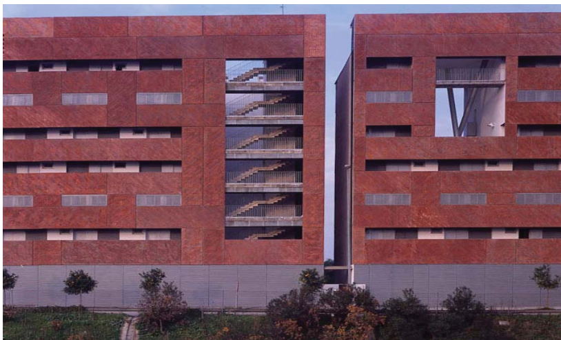
Ref.4.120. Fachada de la S-30
