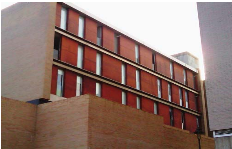
Ref.4.163. Fachada posterior
