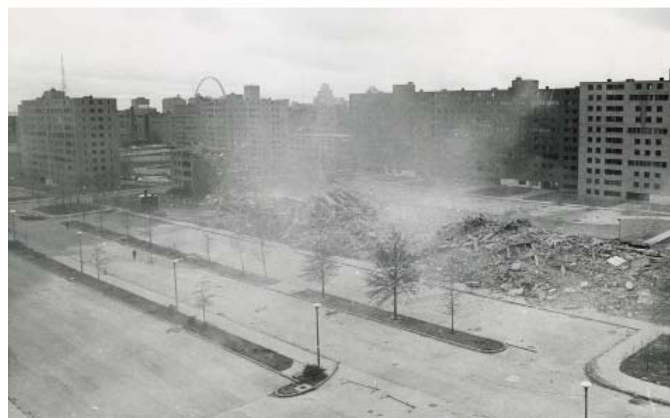
Ref.2.21. Demolición del conjunto Pruitt-igoe, Sant Louis, Missouri, 1972. Arquitecto Minoru Yamasaki
