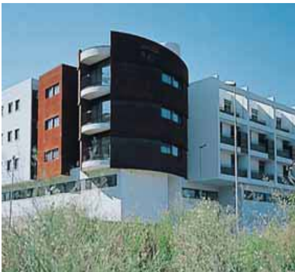
Ref.4.72. Esquina de conjunto, en la que se observa el cambio de material
