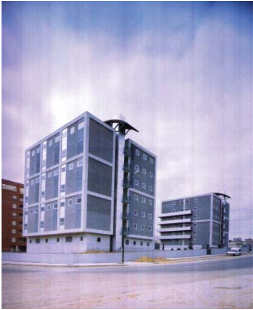
Ref.4.14. Vista actual de las torres
