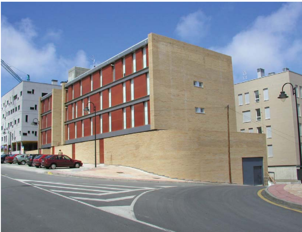
Ref. 5.31. Edificio de viviendas construido de Elio García, Carlos Rodríguez y Javier Rodríguez, Avilés, Europan 5
