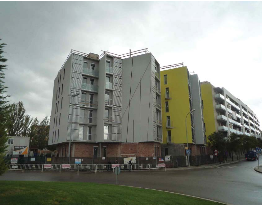
Ref.4.181. Vista del conjunto
