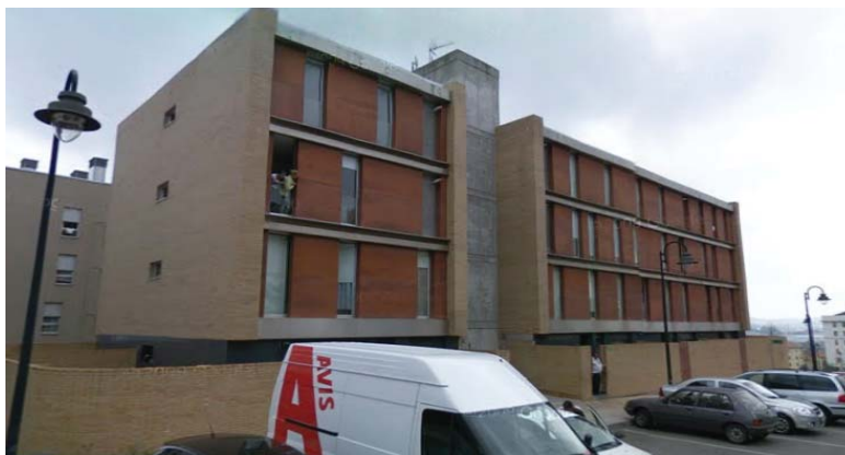
Ref. 4.164. El edificio habitado
