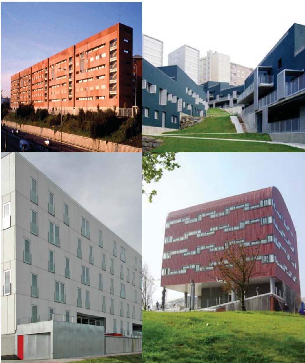
Ref. 5.27. Edificios de viviendas construidos de European 4
