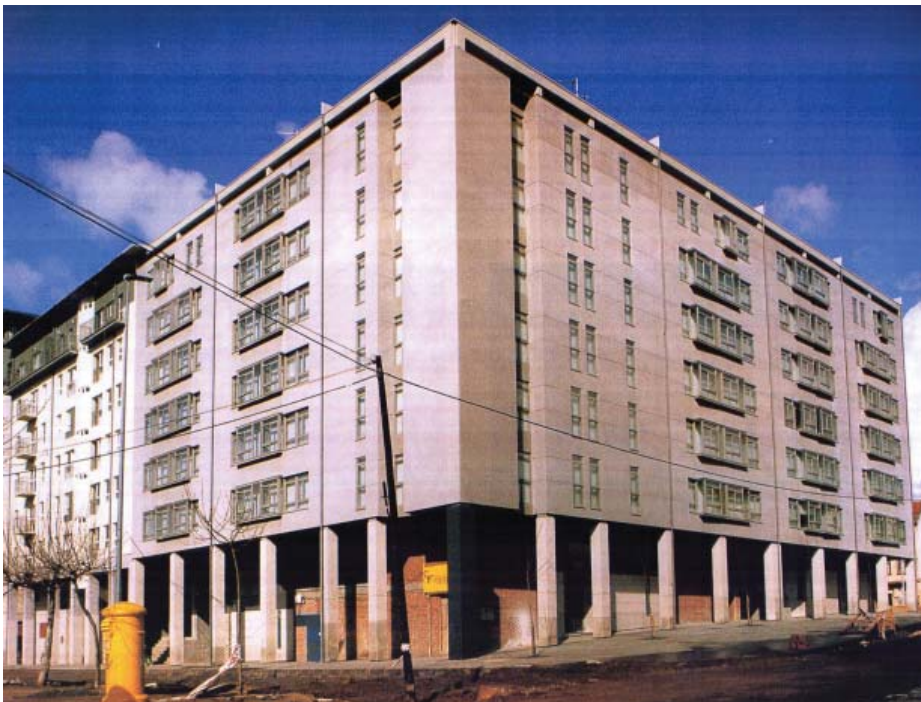
Ref. 5.20 Edificio de viviendas construido de M a Concepcion Carneiro y Cándido López, Ferrol, Europan 2
