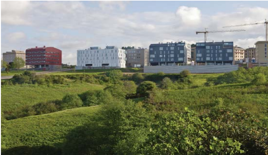
Ref. 4.168. Vista del conjunto
