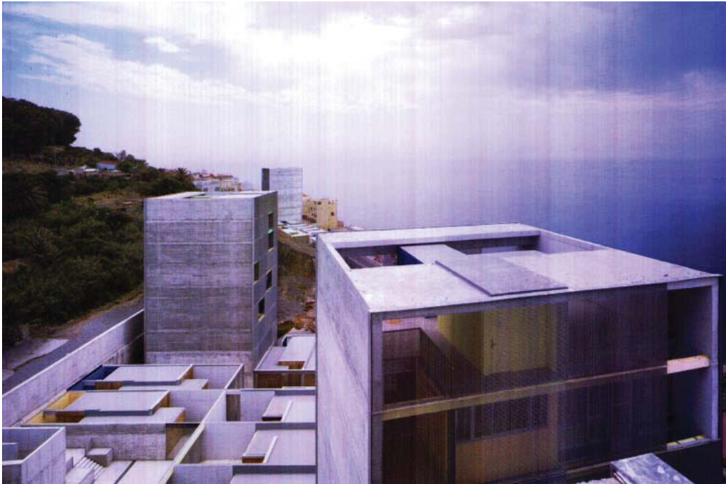
Ref. 5.30. Edificios de viviendas construidos de José Morales y Juan González Mariscal, Ceuta, Europan 5
