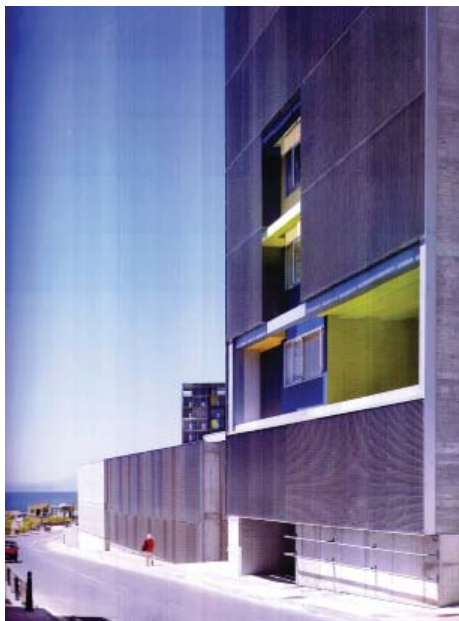
Ref.4.157. Vista desde la calle
