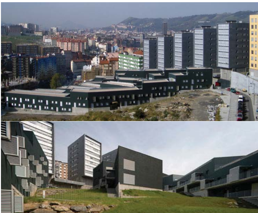
Ref.4.131. Proyecto construído
