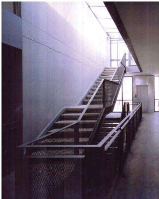
Ref.4.17. Escalera y rasgadura de luz
