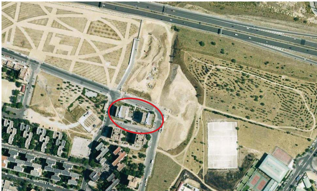
Ref.4.12. Solar donde se construyen las torres frente a la M-40
