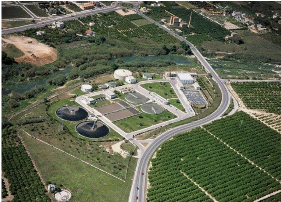
Figura2.2. Depuradora de Gandía. Fuente ( https://www.epsar.gva.es/sites/default/files/2018-04/418.jpg ).
