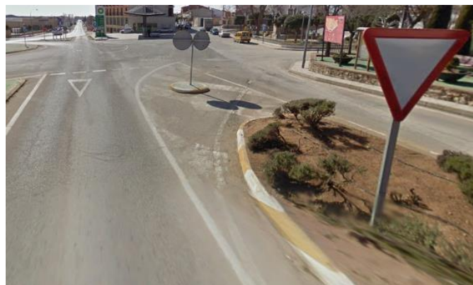
Figura 14: Señal vertical respecto a su línea de detención situada a más de 15m
