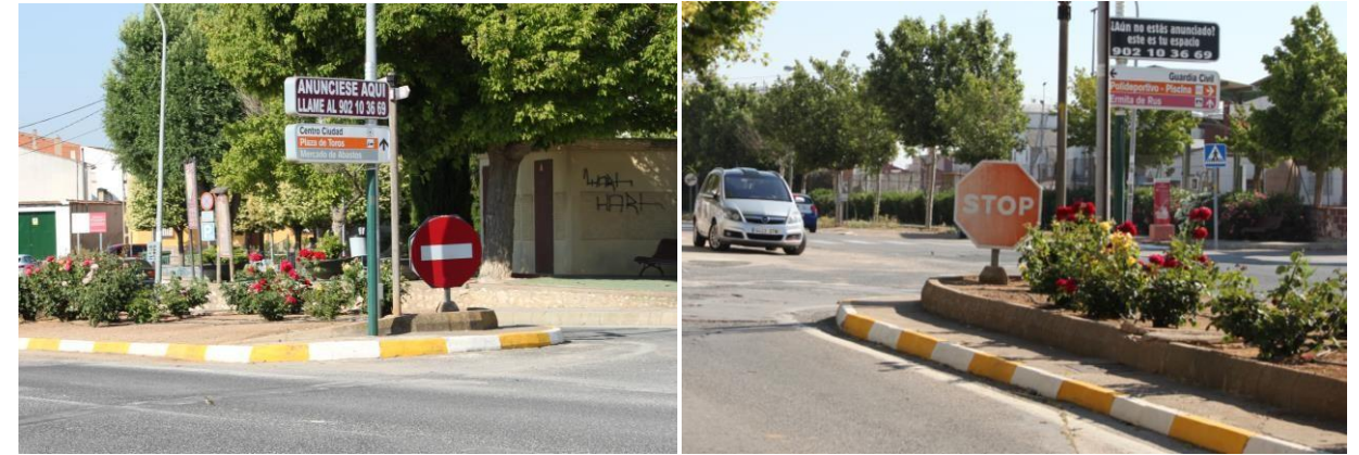
Figura 10: Señales con altura inferior a 2,2 m
