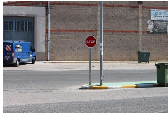
Figura 17: Señal vertical sin sus marcas viales correspondientes
