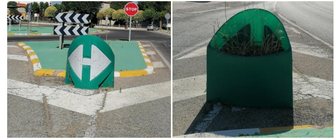
Figura 18: Hito de vértice con color desgastado y vegetación
