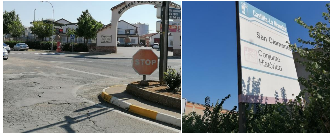
Figura 13: Señales desgastadas en el acceso 1(izquierda) y acceso 2 (derecha)
