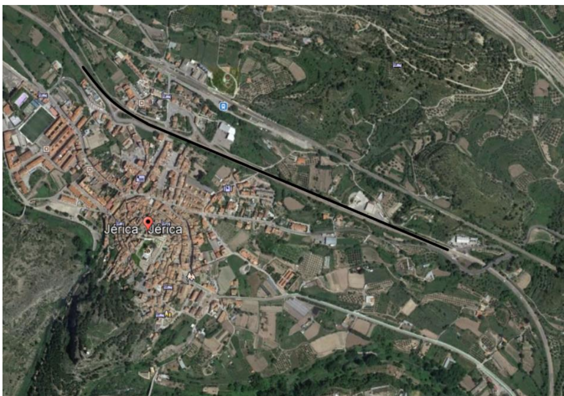
Imagen 5.1.1. Proximidad de viviendas a la N-234 a su paso por Jérica.
