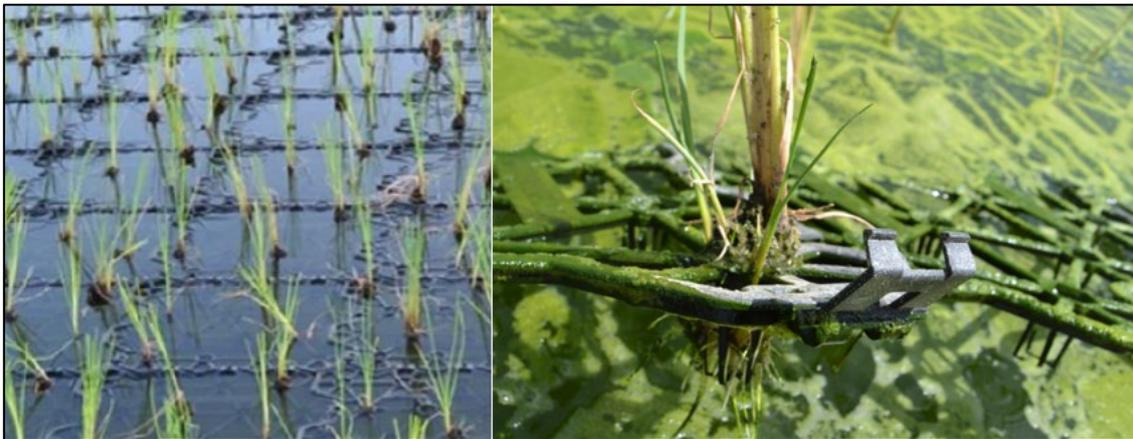
Figura 74. Soportes de helófitas para la fitodepuración de aguas residuales.
