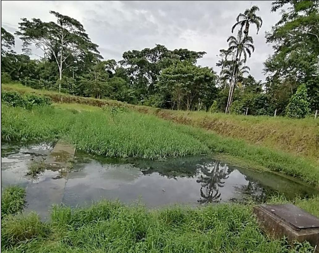
Figura 31. Colmatación a la entrada de un humedal artificial de flujo subsuperficial horizontal en Ecuador.
