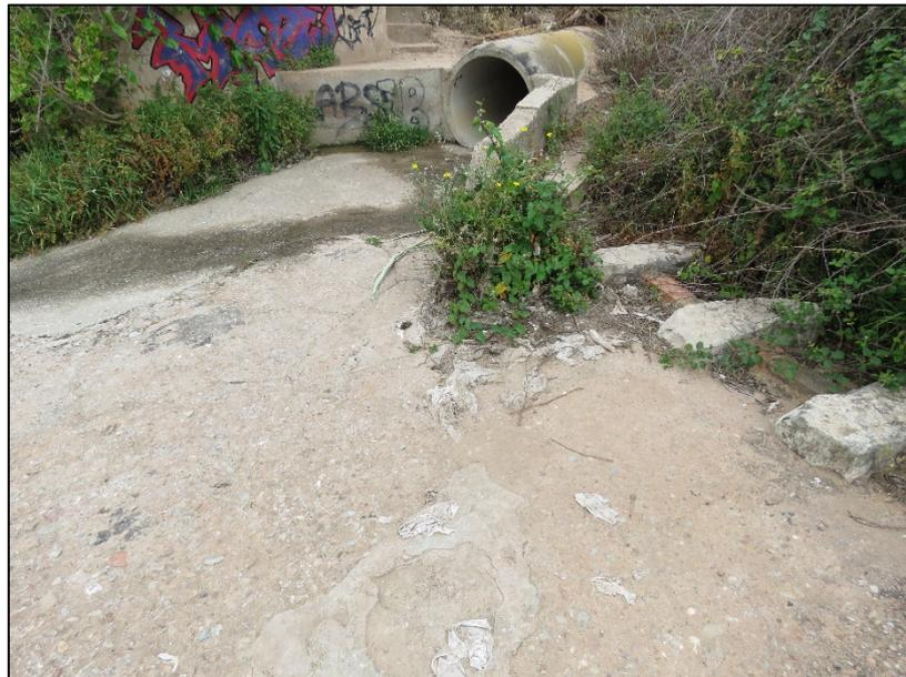
Figura 58. Tubería de descarga de alivio de bombeo de agua residual urbana del barrio el Pilar (Municipio de Moncada) hacia la balsa de Moncada ubicada sobre el barranco Carraixet.
