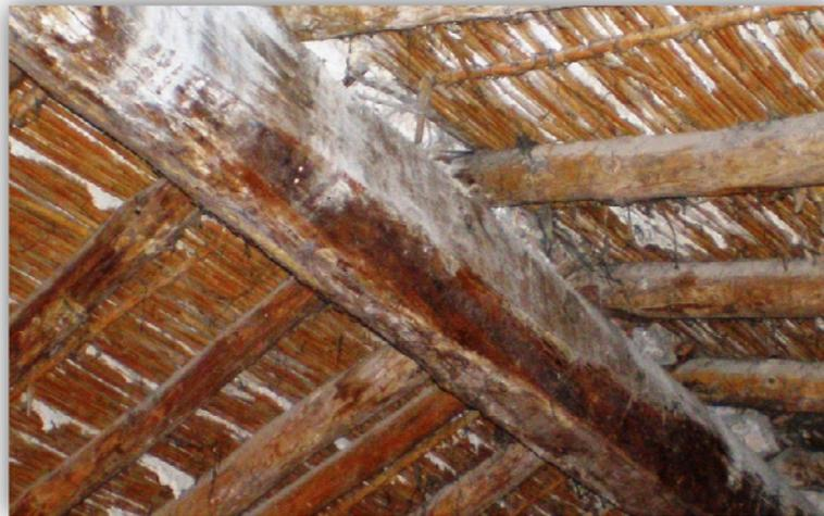
Figura 2.8. Cubierta de madera, yeso y teja cerámica.
