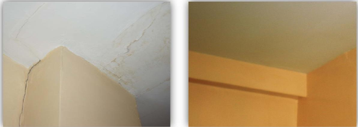
Figura 2.12 Revestimiento de yeso con acabado en distintos colores.
