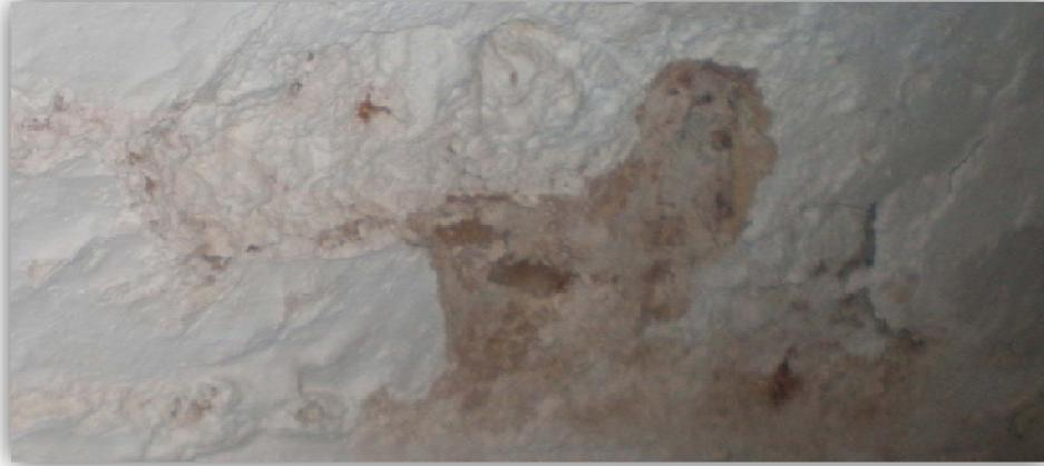
Figura 2.10 Tapial revestido de cal.
