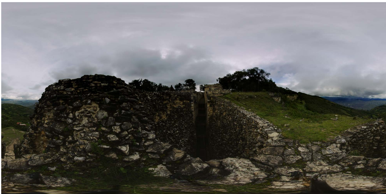
Figura 34: Panorama equirectangular del Hotspot 13: Colapso Fuente: elaboración propia
