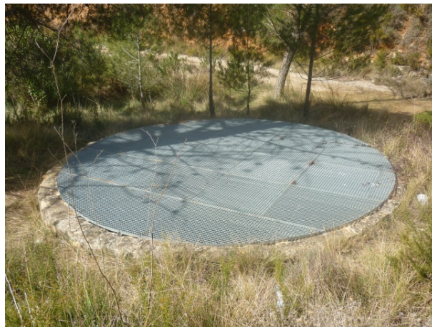
Depósito contra incendios de Juan Gijón.
