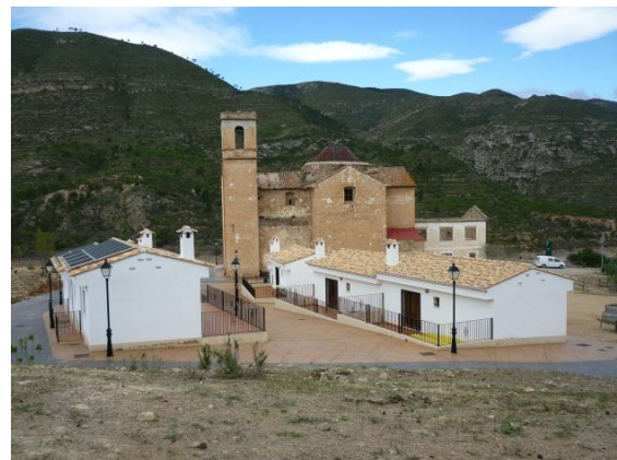
Vista del complejo rural.
