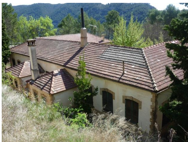
Fachada posterior de la escuela.
