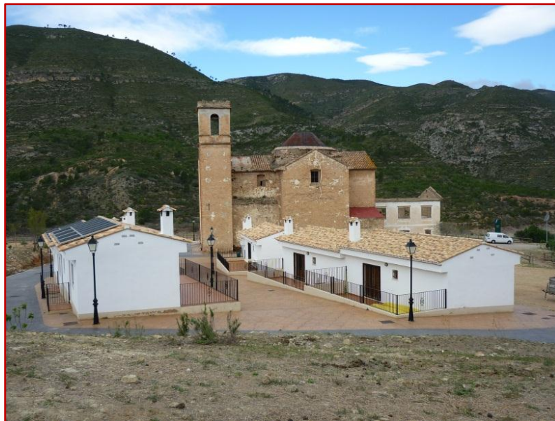
Fig. 5.20. Lo que queda en el antiguo emplazamiento de Loriguilla.
