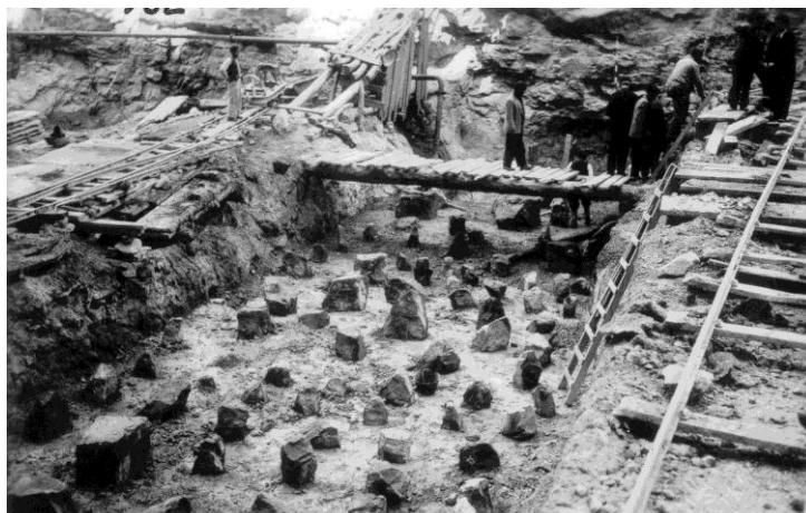
Zona de cantería (cimentos de la presa) 3 de Marzo 1945
