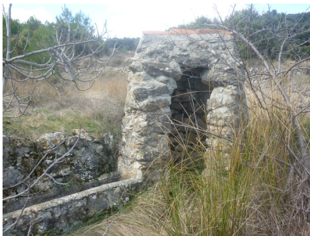
Vista de la fuente Pozo Medien.
