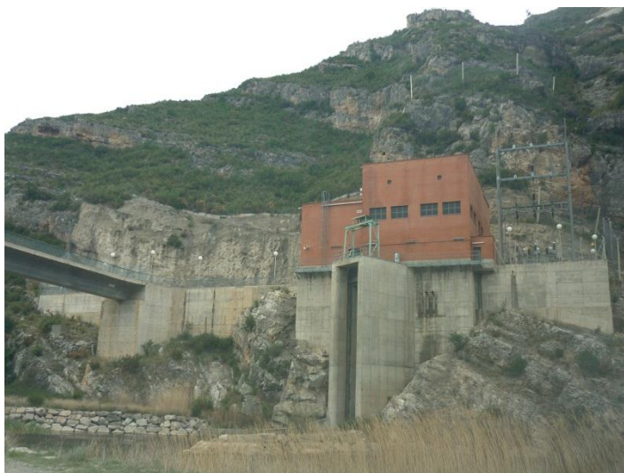
Instalaciones de la central. El canal de Benagéber transcurre montaña arriba-
