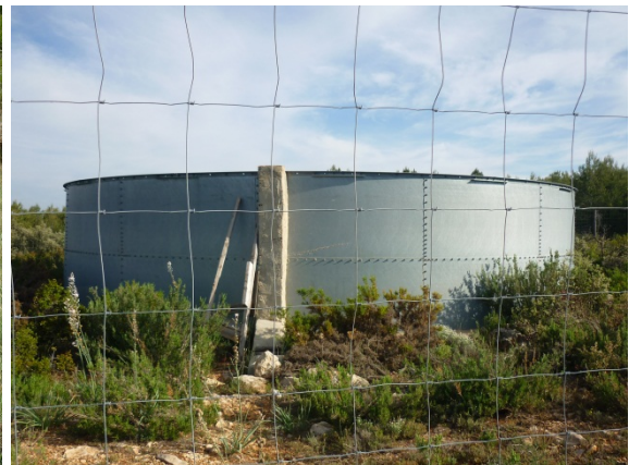
Depósito contra incendios.
