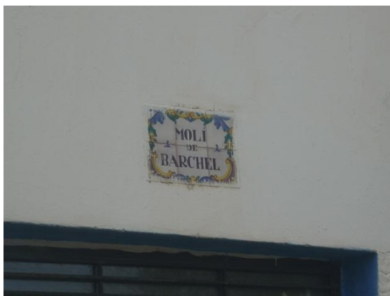
Detalle en fachada principal.
