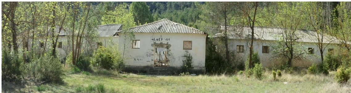
Panorámica exterior de la fachada principal (orientación Norte).
