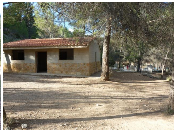
Edificio de aseos.
