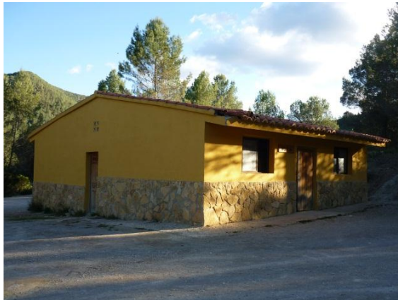
Edificio de aseos.
