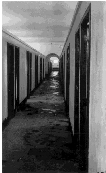
Pasillo distribuidor de las celdas o habitaciones del albergue.
