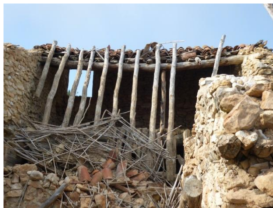
Detalle de los materiales empleados en su construcción.
