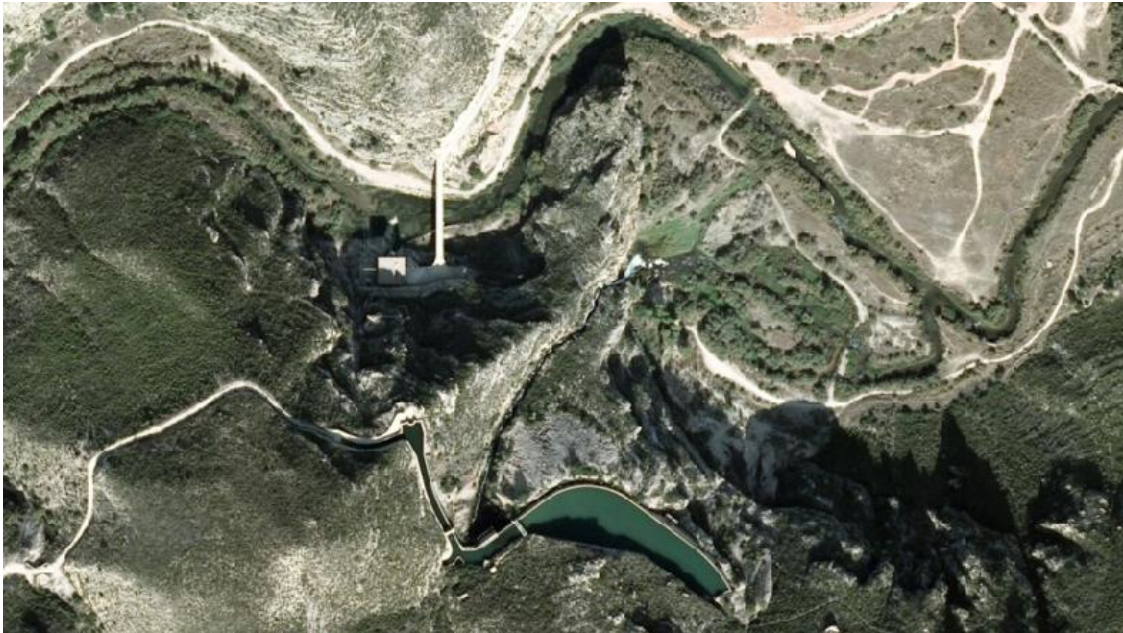
Vista aérea de la central eléctrica. (Con el puente de acceso sobre el río Turia y el canal de Benagéber en la parte superior) Fuente: visor web de cartografía de la CITMA.
