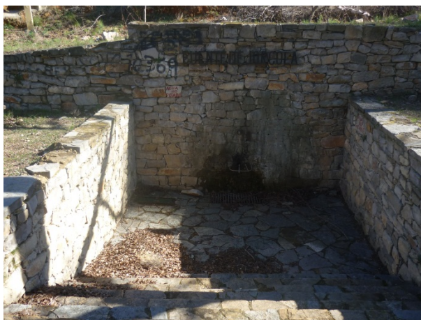
Acceso a la fuente desde las escaleras.
