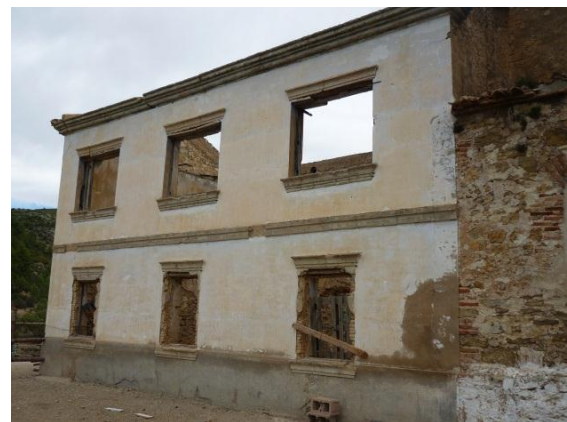
Fachada oeste (posterior).
