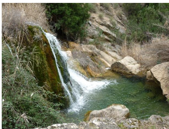
Salto del agua a la salida de la presa y que forma la balsa de las ratas.
