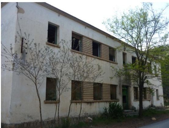
Fachada posterior orientada al Oeste.
