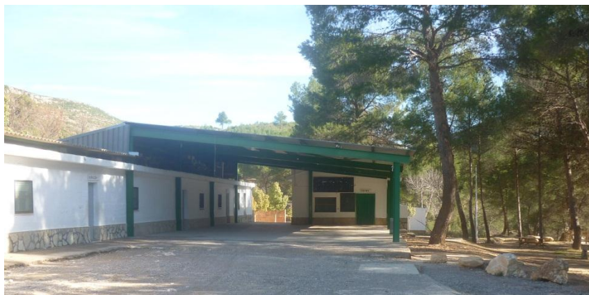
Albergue de Puente Alta.
