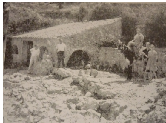
Vista del lavadero junto a la fuente.
