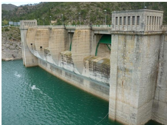
Vista de las compuertas.
