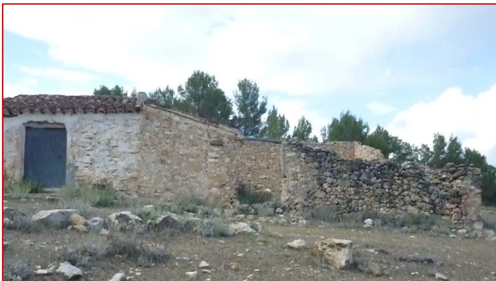
Fig. 6.8. Foto del corral en ruina total anexo a la casa.
