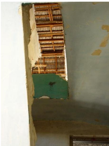
Foto interior tomada desde el hueco de la escalera, se observa la estructura de madera de la cubierta
