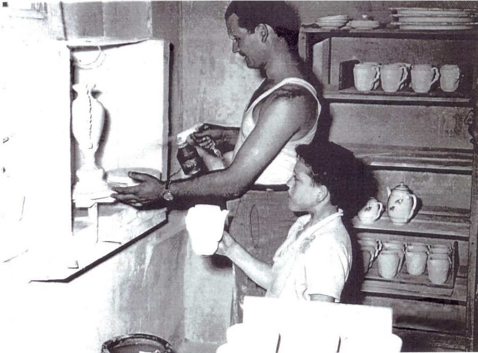
Figura 19. Operario difuminando el vidriado a una pieza. 1965. Archivo Carlos Sanchis
