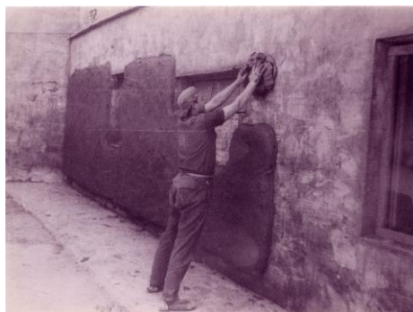
Figura 6. Operario pegando el barro en la pared de yeso para que este pierda agua. A. C.S
