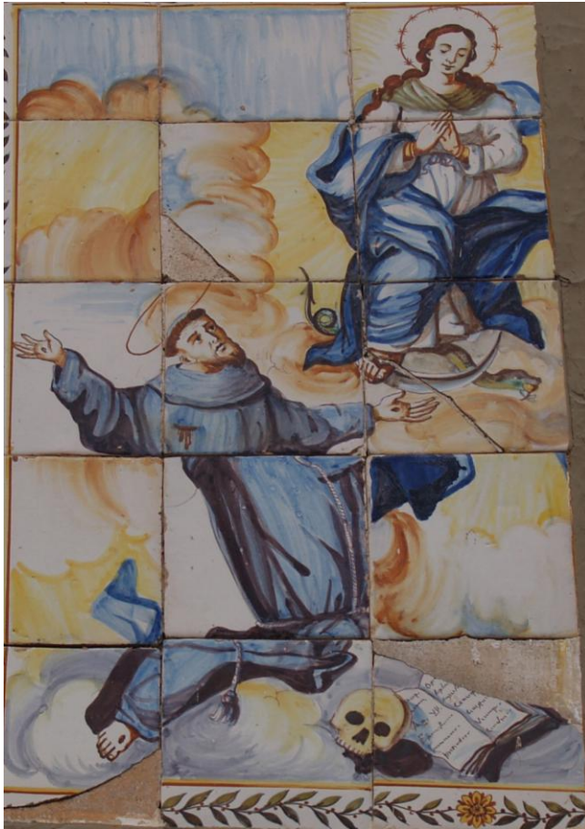
Figuras 31. Intervenciones inadecuadas sobre paneles cerámicos. Rotgle.
