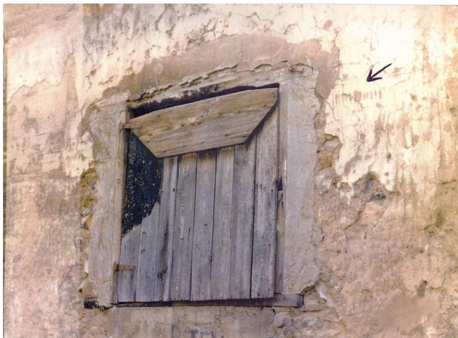
Figura 24. Ventana por donde se adicionaban las haces o manojos de leña para cocer los hornos morunos. A la derecha se puede observar la contabilidad que utilizaban, cada 50 fajos una línea. 1969. Archivo Carlos Sanchis
