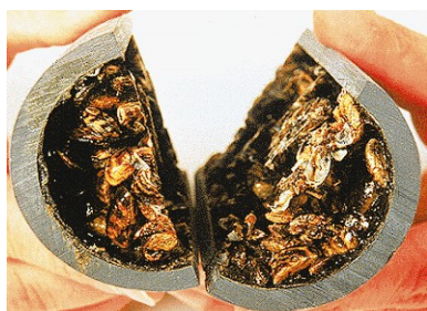
e) Tubería obstruida por el mejillón cebra
