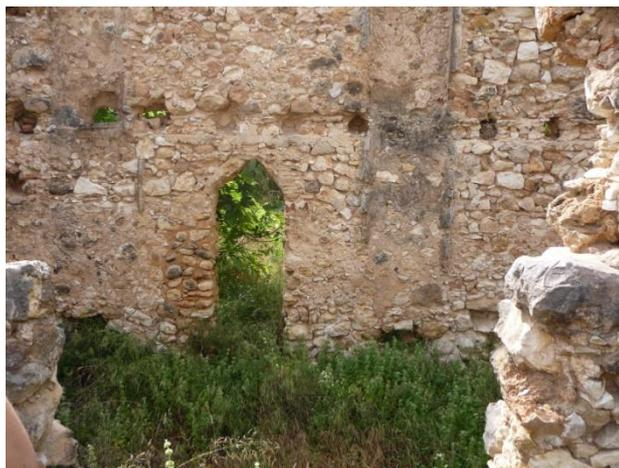
Fuente 7.2.2: Detalle apollo de las vigas en el muro
