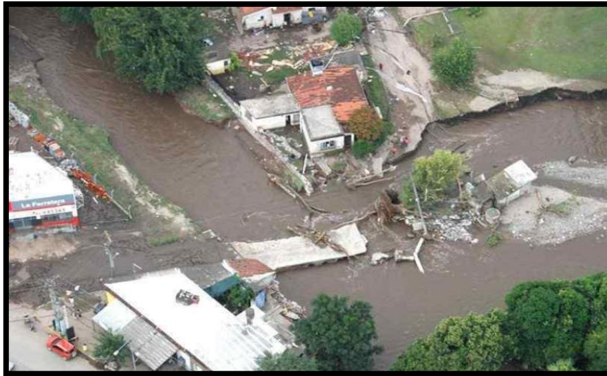
Figura 70: Estado de algunas viviendas y márgenes del río Jesús María luego de las fuertes crecidas del año 2015. Fuente: Diario La Voz del Interior.
