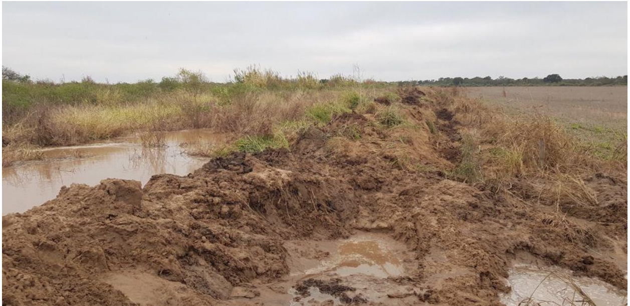
Figura 11: Trabajo de emergencia para obstruir el desborde del río Jesús María dentro del tramo señalado en Figura 1.
