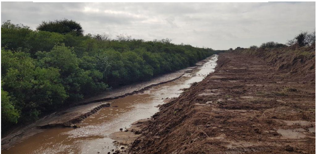
Figura 10: Trabajos de mantenimiento sobre río Jesús María.
